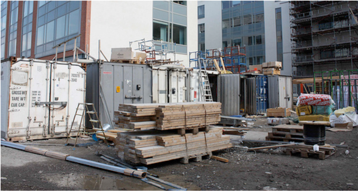
Bild 16 Containers för lagerhållning på byggarbetsplatsen
