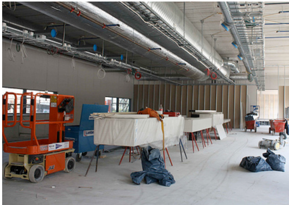
Bild 19 Gipsskivor placerade på det kommande arbetsmomentets plats
