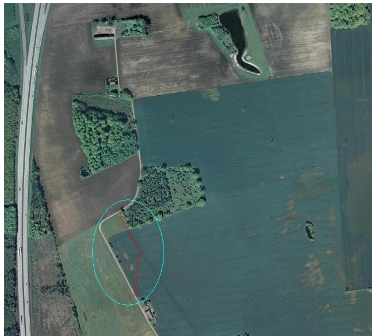
Figur 7, omläggning av befintliga Tostarpsvägen (Flygfoto: WSP 10100285)
