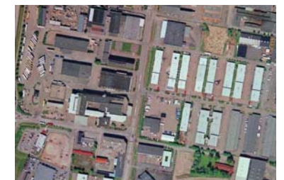
Asfalterade ytor och tung trafik gör industriområdet ogästvänligt för fotgängare.
