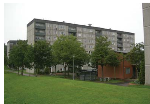
Endast en mindre andel av byggnadsbeståndet representeras av betongklädda höghus. Här: Backa Röd
