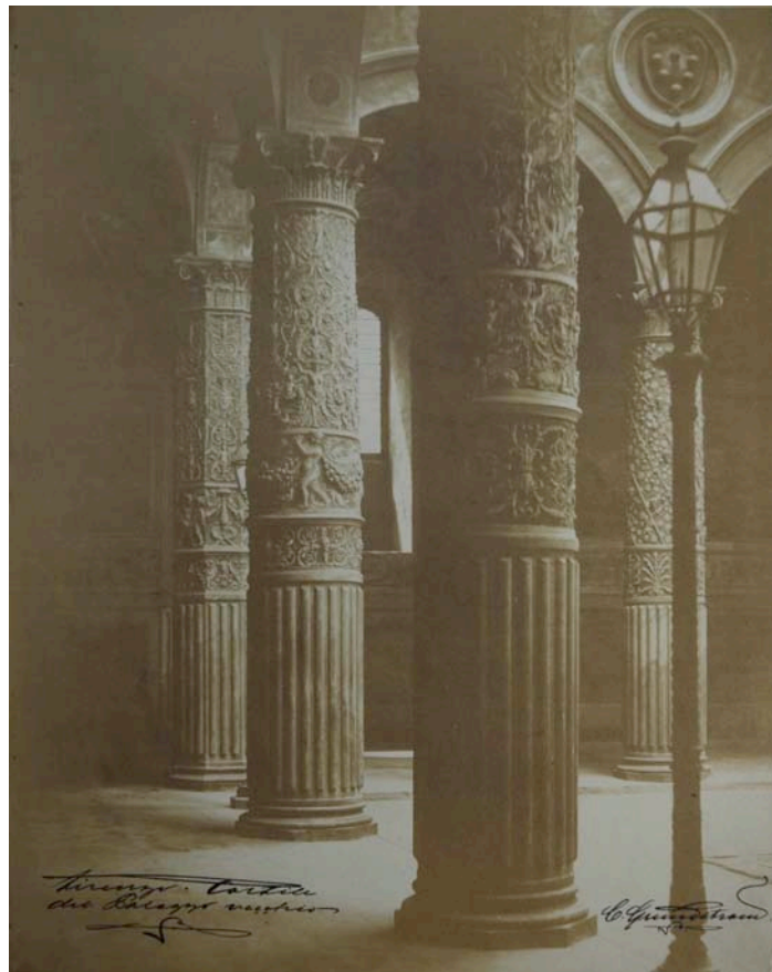
Fig. 30 Palazzo Vecchio, Florens. Innergård
