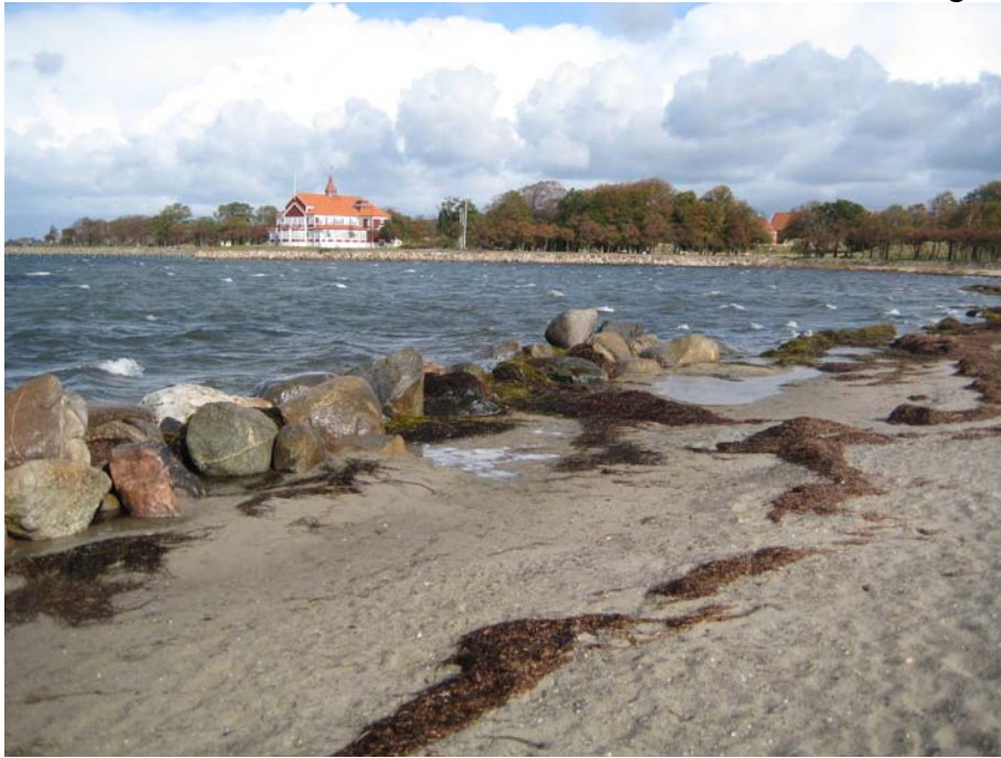
Figur 2-11 – Stenar som lagts ut på stranden vid vattentornet.
