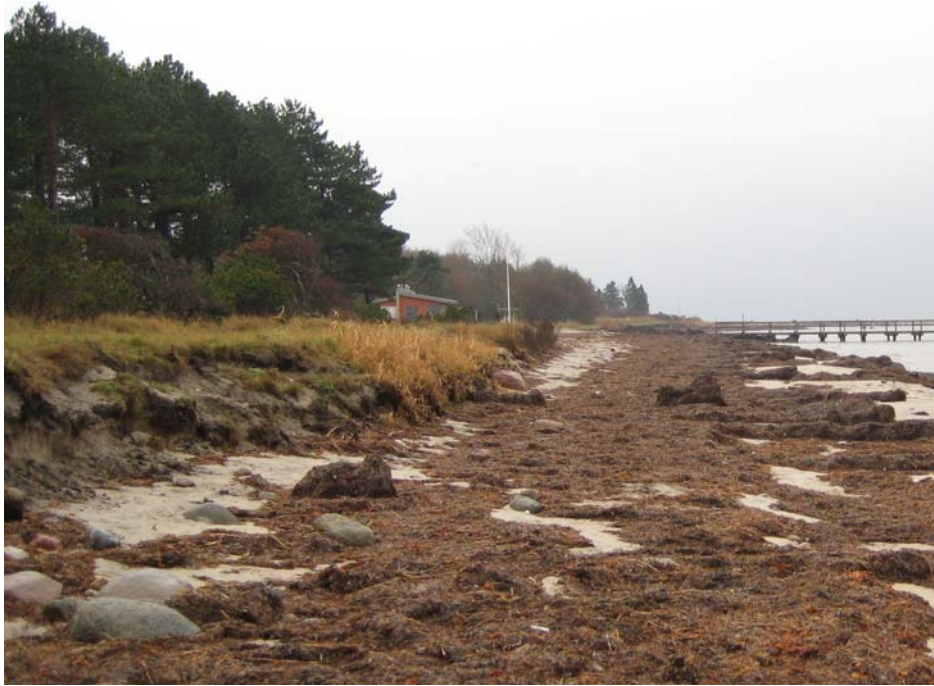
Figur 12-6 – Erosionsbrant vid badstranden mitt emot Lill-Olas väg.
