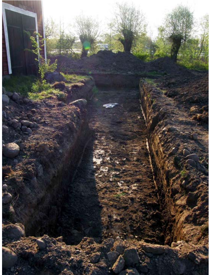
Fig 3. Schakt vid gård 1 2009-04-30 Fotograf: Författaren
