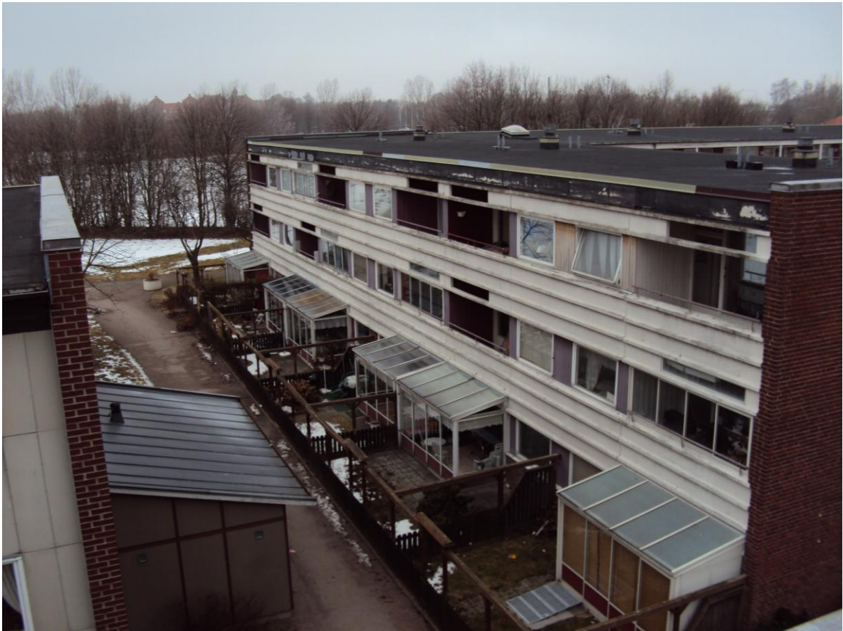
Bild 2:1. Bilden visar en likadan fasad som exemplets östra fasad, med balkonger och fasadskikt.
