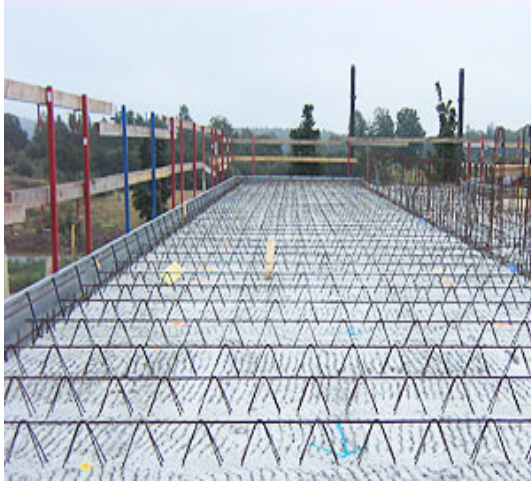
Figur 7.2. Plattbärlag innan pågjutning. ( http://www.finja.se )
