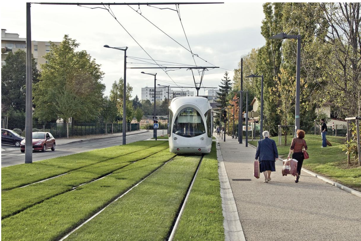
Figur 10 Bilden är tagen i Lyon och visar ett exempel på spårväg i avskilt område med grässpår (Medgivande från Thomas Johansson ©).
