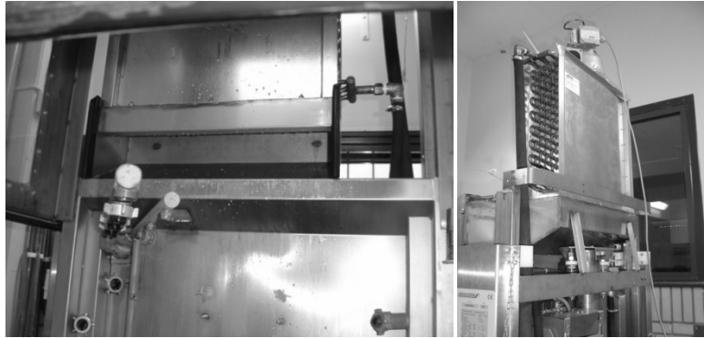
Fig. II Kylbatteriet monterat, t.v. framifrån med huven helt öppen, t.h. bakifrån med huven i läge för energiåtervinning.
