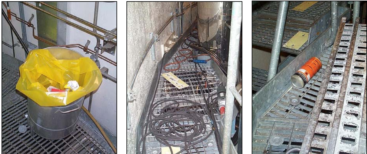
Figur 23 Bilder som visar soptunna utan lock, kablar på gretingplan och kvarlämnad sprayburk.
