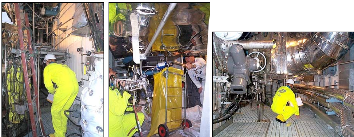
Figur 25 Bilder som visar trånga passager och besvärliga arbetsplatser i O1:s reaktorinneslutning.
