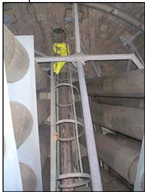
Utrymningsväg från wetwell.
