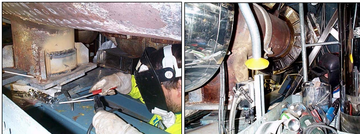
Figur 27 Bilder över pågående svetsarbeten på system 311 i O1:s reaktorinneslutning.
