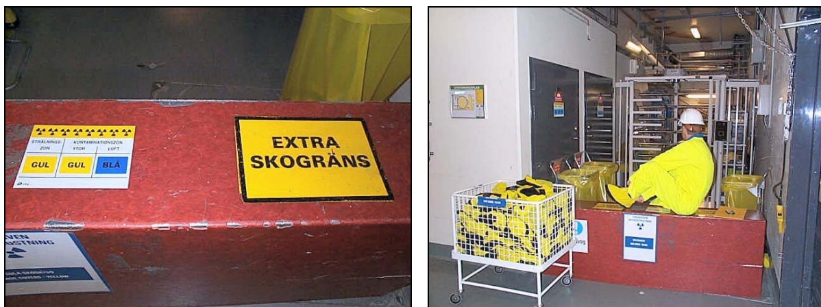
Figur 21 Bilder som visar extra skogräns vid inpassage till O1:s reaktorinneslutning.
