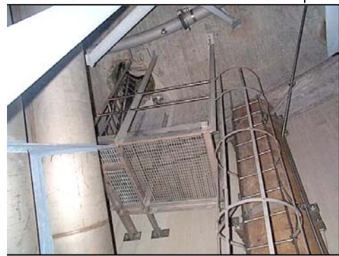
Alternativ utrymningsväg från wetwell.
