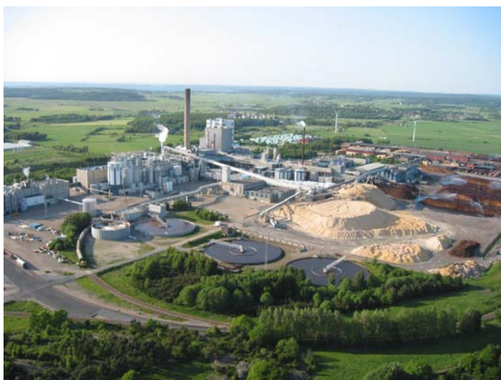
Figur 5-2, Bild över fabriksområdet på Södra Cell Värö
