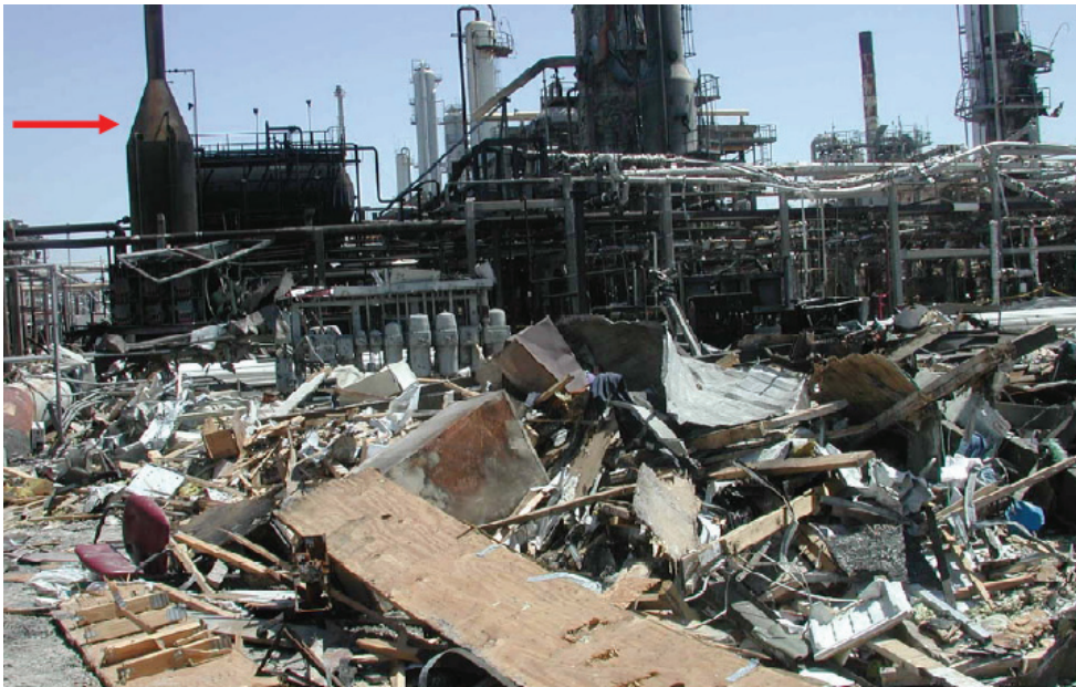
Figur 15 Förstörda "trailers" vid olyckan i Texas. Pilen markerar utsläppskällan, "the blow down drum" Övertrycket som de utsattes för har uppskattats till 2.5 psi vilket motsvarar 0,17 bar (CSB ,2007).
