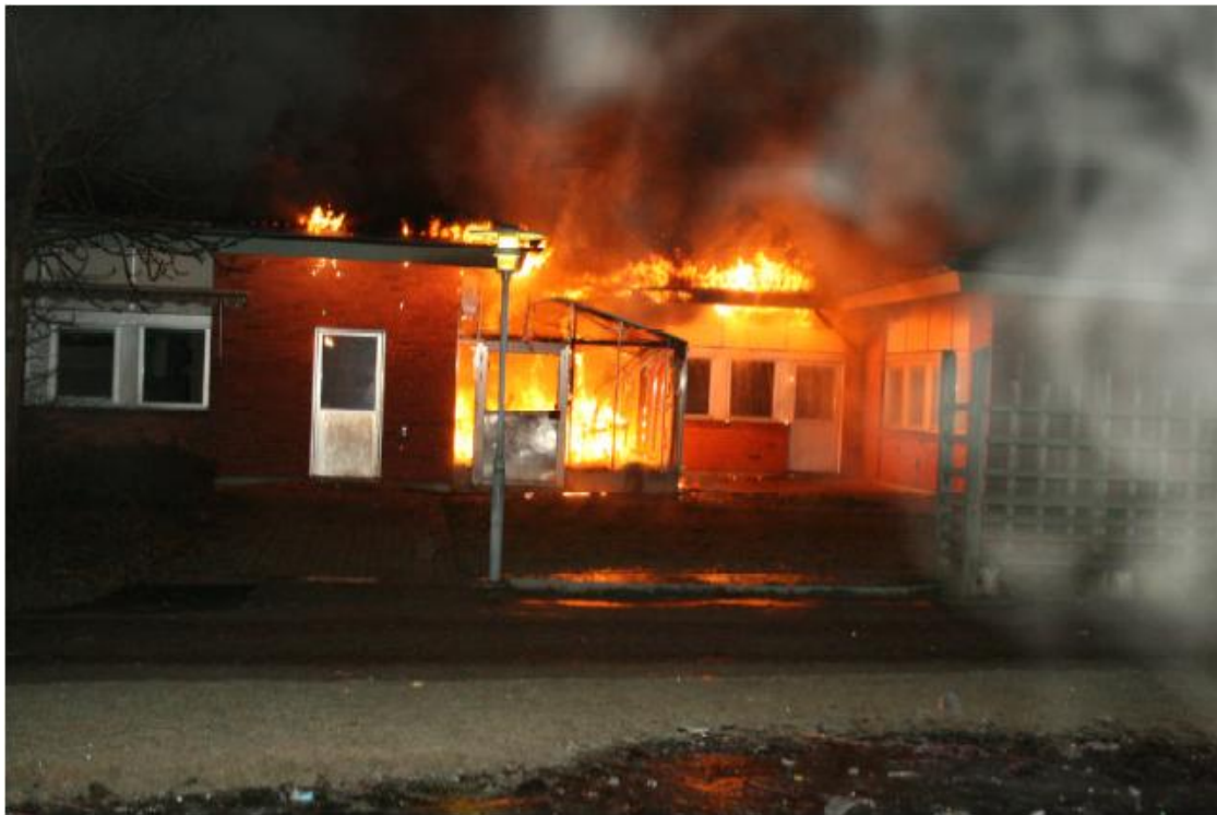
Bild 3.1 Växthuset där branden startade (Åberg, et al., 2009).
