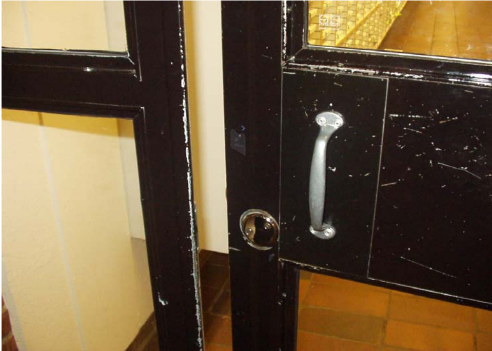
Fig. 6.3 Exempel på dålig design. Dörren öppnas bortåt men handtaget uppmanar användaren att dra dörren mot sig.
