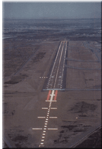
Bild A1 Inflygningsljus med sidobaretter (PCR, 2005).
