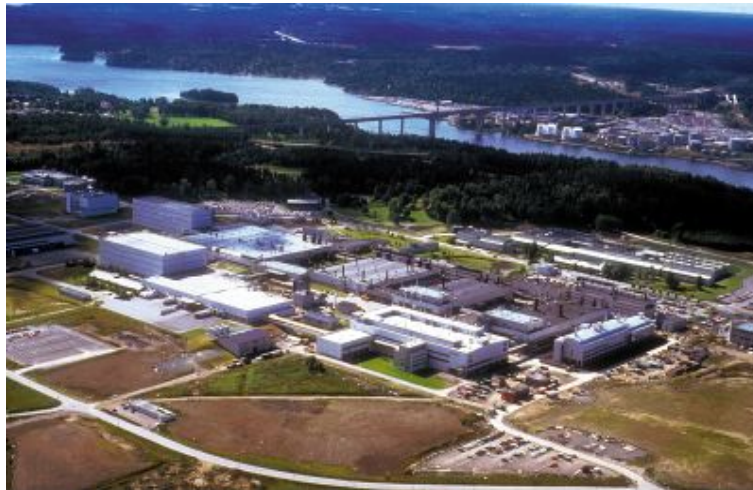
Figur 1.1. Flygbild över anläggningen i Gärtuna, Södertälje. (Källa: AstraZeneca (2006).)
