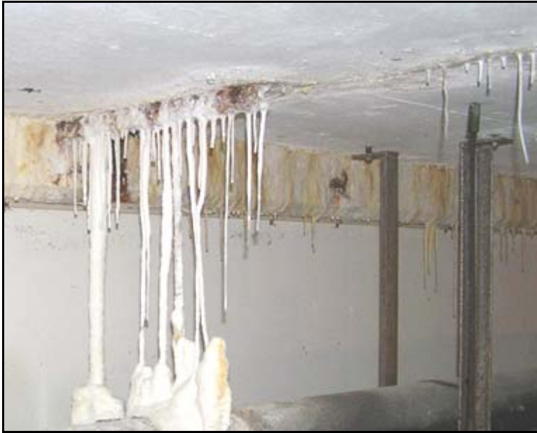
Figur 6.9 Otät gjutfog i bassängdäcket.
