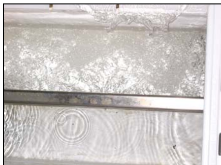
Figur 3.4 Exempel på en ränna som är delad med hjälp av en rostfri stålprofil. Övre delen leder bort bassängvattnet och nedre delen städvattnet.
