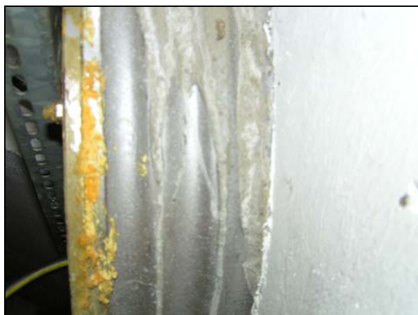
Figur 9.10 Genomföring med Permurrör eller liknande.
