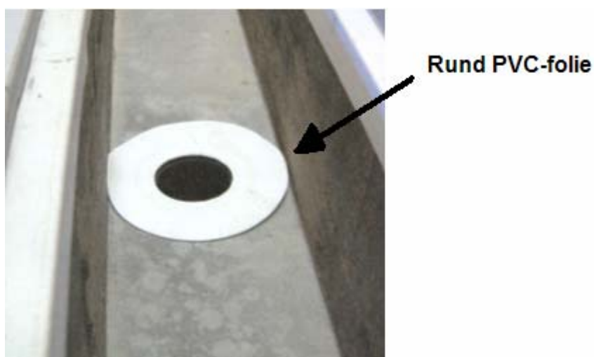
Figur 12.5 Rund folie som svetsas på kraghylsan för att sedan sammansvetsas med bassängens PVC-folie [15].
