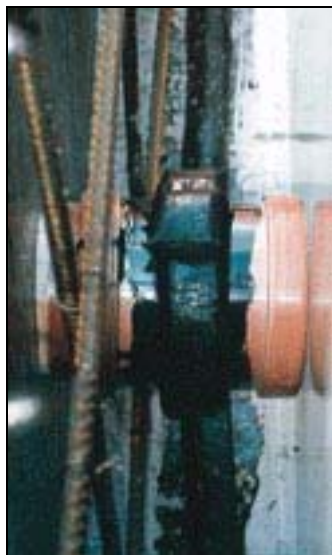
Figur 9.8 Röret installeras redan vid gjutning. Här med fuktspärr av typen SynkoFlex [34].
