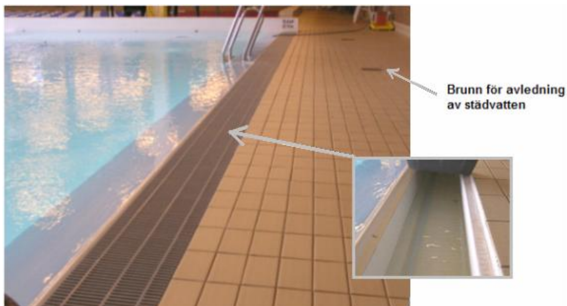
Figur 3.5 Bassäng med odelad golvränna. Fallet till brunnen ska hindra städvattnet att nå bassängen.
