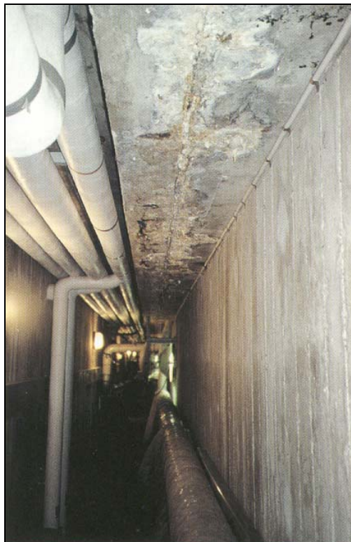
Figur 4.6 Inspektionsgång runt betongbassäng [2].
