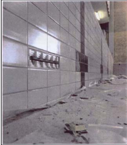
Figur 14.4 Vattenanod inbyggd i klinkerbeklädnaden [49].
