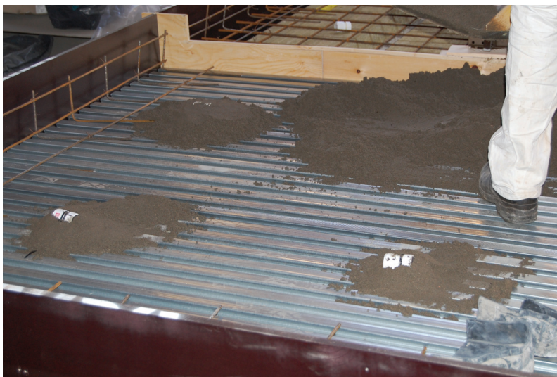
Figur 8. Noderna under ingjutning.
