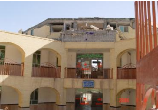
Fig. 71. Baghiatollah sjukhuset. Tredje våningen kollapsade in på den andra våningen. Dålig kvalitet på betongen samt osymmetrisk tredje våning är de bidragande orsakerna. (IIEES)
