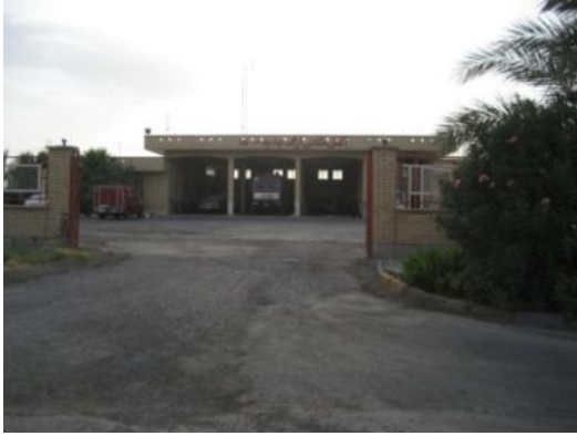
Fig. 102. Den nya brandstationen
