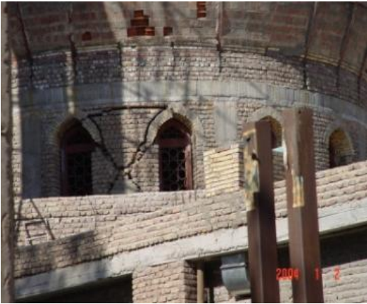
Fig. 79. Moské Abolfas. Väggen mellan fönstervalven under kupolen fick X sprickor endast på de väggar som var vinkelräta mot den horisontella kraften. Anledningen beror på ett konstruktionsfel mellan det horisontella bandet och kupolen. Kupolen skulle ha fortsatt hela vägen ner till det horisontella bandet men byggdes istället en meter ovanför bandet. Stålbandet som placerats under kupolen var otillräckligt för att klara av ovanifrån kommande tröghetskrafterna. (IIEES)
