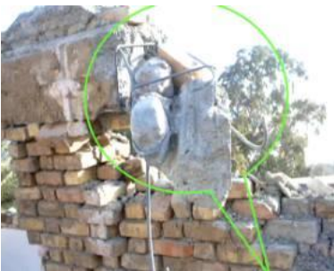
Fig. 70. Stora stenar i betongblandningen var ett problem som inte var begränsat till ett fåtal hus, det var till och med en av anledningarna till varför betongen i Baghiatollah Sjukhuset brast. Bilden visar betongblandningen i en mur som tillhör en skola. (IIEES)
