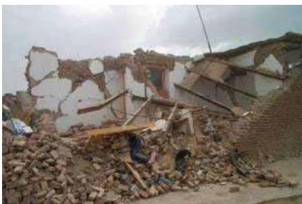
Fig. 41. Avsaknaden av band. Bostadshus i Baravat med stålbalkar på taket. Samtliga i familjen överlevde tack vare att de valde att sova ute på gården efter förskälven.
