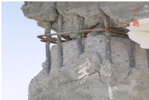
Fig. 63. Avsaknaden av 135° kroken i det horisontella bältet ledde till att de vertikala stängerna kunde tryckas ut och krossa betongen. Ett annat problem som uppstod i pelare var att pelare oavsiktligt fått flera skikt. Pelare byggs upp i flera omgångar, våning för våning och när man påbörjar ett nytt skikt så är det viktigt att man rensar på toppen av pelaren och skrapar bort vattnet som tryckts upp under torkningstiden. (IIEES)
