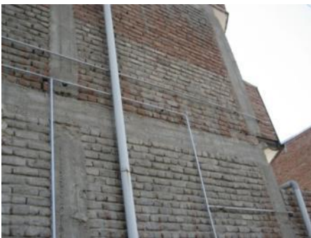
Fig. 130. Betongpelare som tar slut mellan första och andra våningen men som sedan fortsätter från en annan position.
