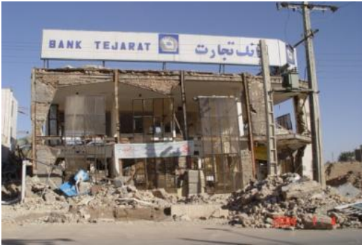
Fig. 86. Felplacerade diagonala stödbalkar i fronten. Syftet var att ha stora fönsterpartier men resultatet blev att de diagonala stödbalkarna tryckte ut väggen. En annan bank kollapsade till grunden på grund av att man byggt ut en mezzanin. Det nya golvet tryckte ut väggen. (IIEES)
