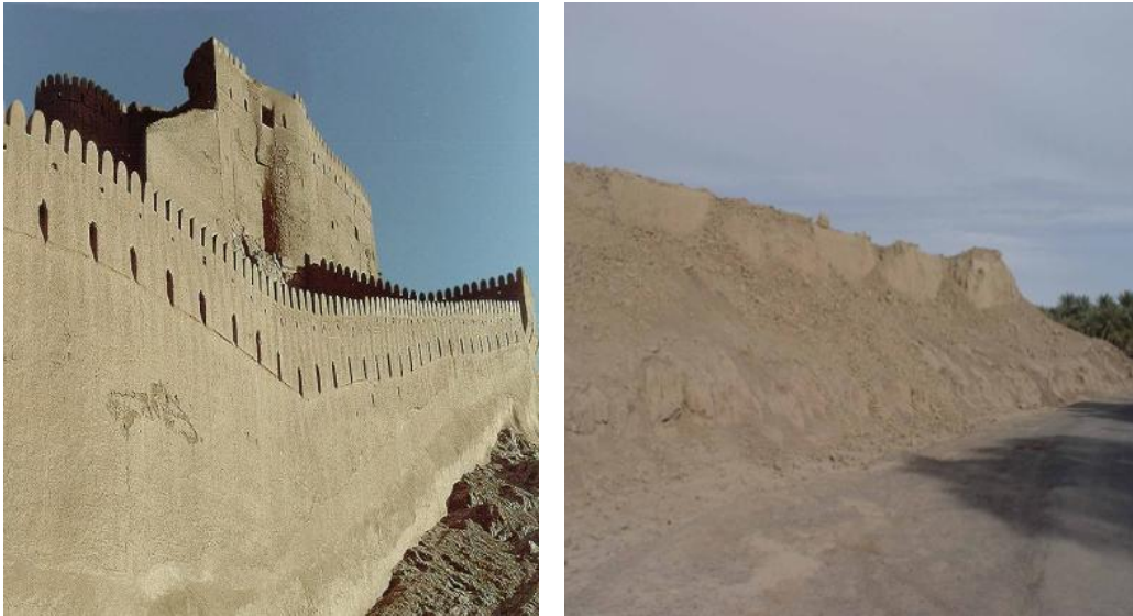
Fig. 88. Före och efter bilder av Arg-e-Bam (IIEES)
