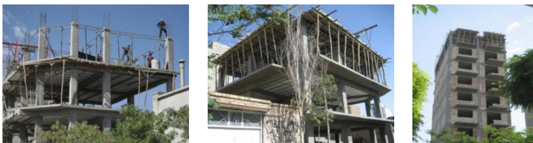
Fig. 141. Det är numera standard att bygga golven och taken med lätta golv.
