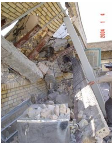
Fig. 67. De longitudinella stängerna skulle bindas ihop med en krok med 90° vinkel i hörnen, men bilden visar att armeringen når precis till hörnen utan någon krok. Dessutom ska stängerna överlappa varandra där de tar slut vid långa balkar. Armeringen skulle överlappa varandra där de möttes.
