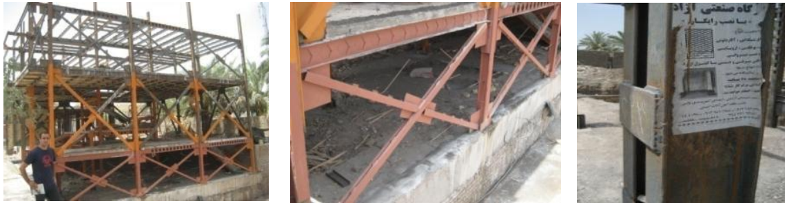
Fig. 115. Väl fogade stålstommar. Iranska svetsare måste numera ha godkänd utbildning för att kunna arbeta. Bilderna ovan är tagna i Bam.
