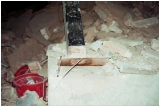
Fig. 57. Basplattan lossnade från fundamentet. Iranska experter har kommit fram till att bästa basplattan är när stänger från fundamentet går genom plattan och en mutter låser ihop dessa stänger med plattan. I vissa fall saknade stänger en krok i betongen och därför släppte. Pelaren fogas sedan ihop med basplattan med hjälp av mindre stålplattor. Att basplattor eller att pelare släppte från basplattan var utbrett problem. (IIEES)
