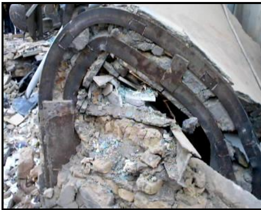
Fig. 52. Pelaren har böjts på grund av att stålplattorna, som lappar ihop stålpelarna, var för långt ifrån varandra. Iranska byggregler kräver att de ska vara högst 50 centimeter ifrån varandra. Pelaren utsattes därför för kraftiga vridningsmoment. (IIEES)
