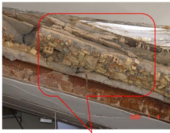
Fig. 64. Imam Khomeini sjukhuset. För tjockt och tungt tak med flera lager av tegelstenar (IIEES)
