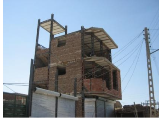
Fig. 131. Byggnader under konstruktion i Ajabshir. Här syns den nya designen av golv tillsammans med väl designade och konstruerade pelare och balkar. Dessa byggnader återspeglar förändringarna i den iranska byggindustrin.
