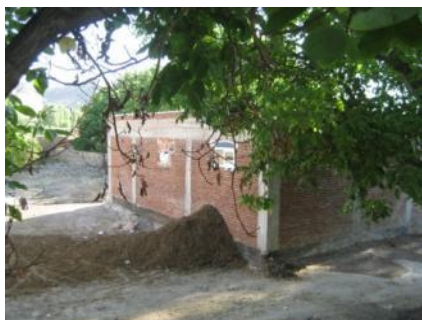
Fig. 139. En by utanför Ajabshir. Detta är en ny byggnad och med stålarmrad betongstomme.
