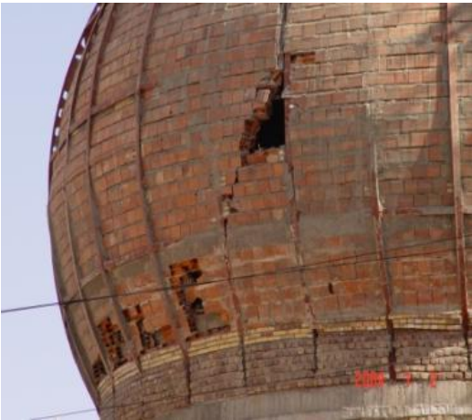
Fig. 80. Moské Abolfas. Kupolen har många mindre band mellan stålstommen över hela konstruktionen men man hade glömt några och kupolen skadades därför på de ställen där banden saknades. (IIEES)
