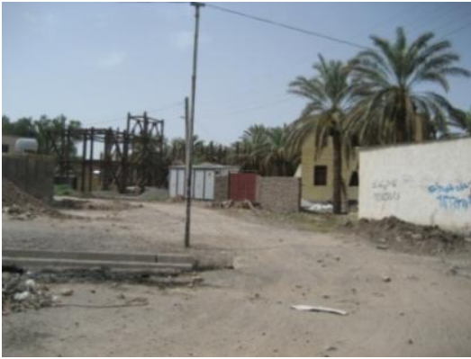
Fig. 97. Så här ser det ut i stora delar av dagens Bam där tillfälliga bostäder ligger sida vid sida med nybyggda hus byggnader under konstruktion.
