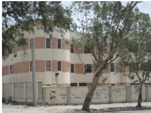
Fig. 106. Gymnasieskola byggt av japaner.
