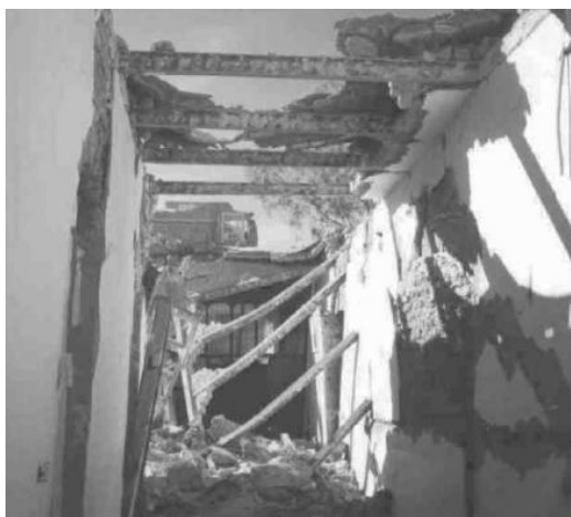
Fig. 32. Otillräcklig balklängd samt dålig förbindning leder till att balkarna glider ur sin position. (Performance of Building Roofs in the 2003 Bam, Iran, Earthquake och IIEES)
