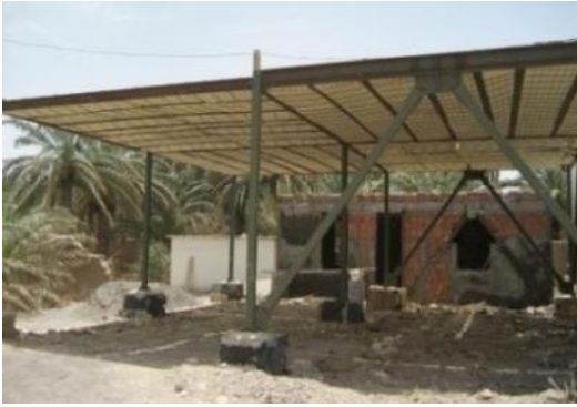
Fig. 111. Frigolittak med flytbetong på används även på mindre hus. Dessa tak och golv är billigare än tidigare tak och golv med tegelstenar. Dessa bilder är tagna i fattiga Baravat och husen tillhör bönder. Stål är dock inte första valet för fattiga iranier men i Baravat och Bam är det myndigheterna som står för alla kostnader för stål och betong (endast för själva stommen och inte för resten av huset).
