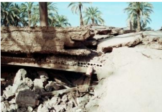
Fig. 49. Visserligen ihåliga tegelstenar och stålstomme men ett alldeles för tjockt lager av takisolering. (IIEES)
