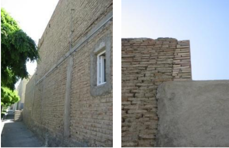
Fig. 144. Horisontella och vertikala band på första våningen medan andra våningen saknar dessa band. Byggnaden är inte äldre än 20 år.
