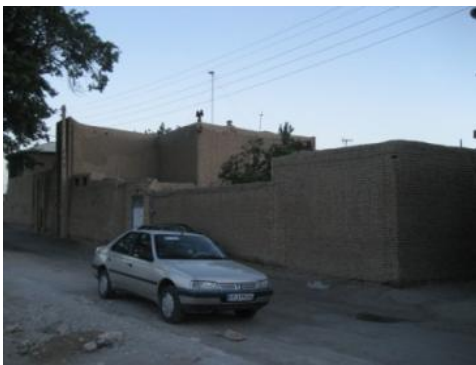
Fig. 124. Det är vanligt i Ajabshir att hus byggda före 1990 saknar vertikala och horisontella band.
