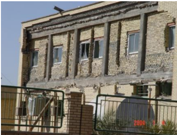
Fig. 47. Iranska byggregler säger att en fasad av tegel bör ej överstiga 5 centimeter i tjocklek, den gör det så ska tegelskiktet armeras med klamrar. Många saknade denna armering och många av byggnaderna som hade detta hade otillräcklig armering. Klammarna ska sitta högst 0,5 meter ifrån varandra i höjdlid och 1 meter i längdriktningen. (IIEES)
