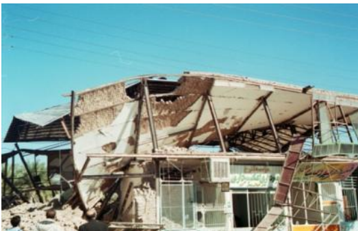
Fig. 54. Olika axellinjer mellan balken och stålpelaren (IIEES)
