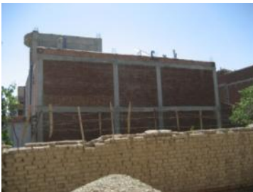
Fig. 136. Horisontella och vertikala band.
