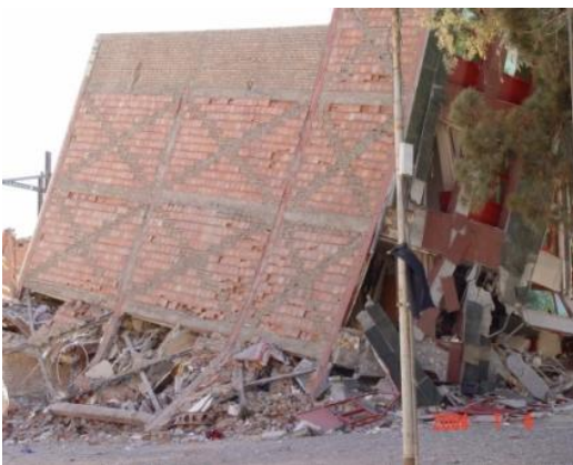
Fig. 87. Mjuk våning. Det är väldigt vanligt i Iran att första våningen på bostadshus består av affärer och butiker. För att få plats med stora fönsterpartier samt ingångar till verksamheterna så väljs diagonala stödbalkar bort på första våningens framsida. Men de installeras på gavlarna samt baksidan. Oturligt så var gavlarna på byggnaden ovan parallella med jordbävningens riktning och framsidan var vinkelrät. Första våningen blev därmed en mjuk våning och kollapsade medan resten av huset hölls ihop. (IIEES)
