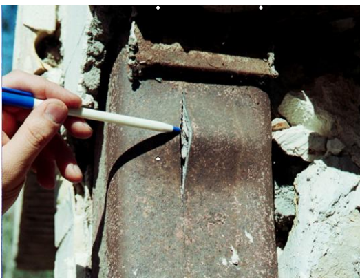
Fig. 55. Den numera förbjudna kvadratiske pelaren. Pelaren släpper där den har hopfogats. (IIEES)
