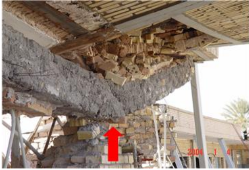
Fig. 65. Taket kollapsade in då balkarna gled ifrån varandra. Dålig betongkvalitet ledde till att betongen som fungerade som murbruk pulveriserades. (IIEES)
