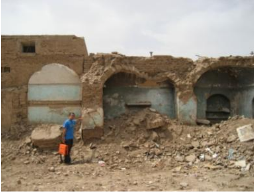
Fig. 37. Bilden visar hur massiva väggar behöver vara för att klara av krafterna från valvtaken. Kraftiga väggar attraherar större tröghetskrafter.
