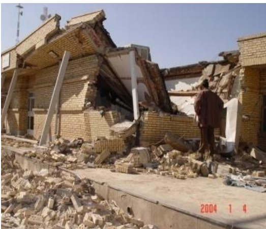
Fig. 64. Imam Khomeini sjukhuset. För tjockt och tungt tak med flera lager av tegelstenar (IIEES)
