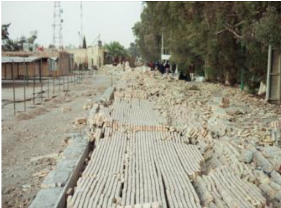
Fig. 46. Avlång mur utan stödpelare och band.( IIEES)
