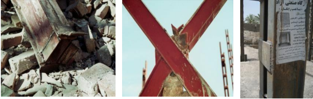
Fig. 56. Dålig fog mellan basplattan och de mindre plattorna på pelaren. Detta ledde till att pelaren blev fristående. Dålig fogning var utbrett problem i Bam. Bilden längst till höger visar en bra fogad platta.(IIEES)
