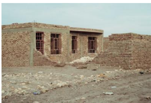
Fig. 60. Ett hus som klarade sig från att kollapsa eftersom man använt sig av både horisontella och vertikala band. Muren, utan horisontella band, kollapsade i jordbävningsriktningen.
