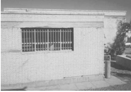
Fig. 34. Tegelhus med jack-arch takplatta. Byggnaden klarade sig undan skador eftersom iranska rekommendationer följts och ett horisontellt band av betong installerats. (Performance of Building Roofs in the 2003 Bam, Iran, Earthquake)
