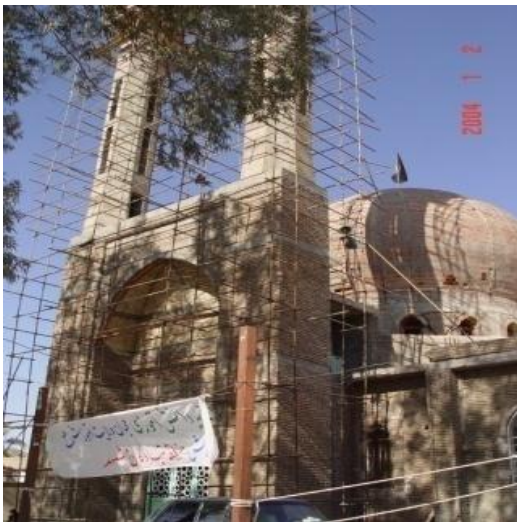
Fig. 78. Moské Abolfas efter jordbävningen. Jordbävningens höga frekvens ledde till att minareterna och entrén betedde sig på olika sätt. Entrén rörde sig mera horisontellt jämfört med minareterna men undkom allvarliga skador tack vare de horisontella banden vid entrén. (IIEES)
