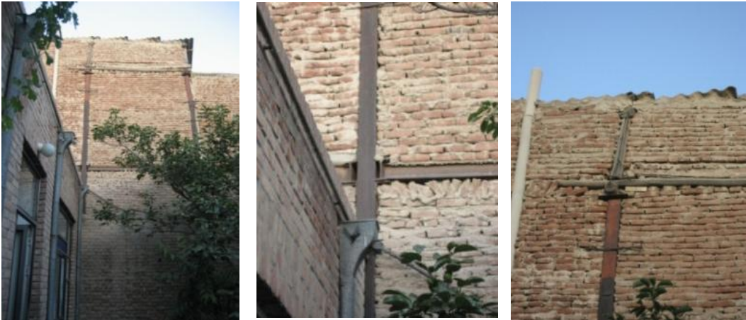
Fig. 121. Detta är ett tre våningshus i Ajabshir med flera allvarliga brister. Den första bilden visar en felaktig design av anslutningen mellan balk och pelare. Det kommer att uppstå farliga vridningsmoment i anslutningen och denna typ av problem fick många hus i Bam att kollapsa. Det andra problemet är att stålpelaren plötsligt tar slut på tredje våningen men ersätts istället av en träpelare med en väldigt dålig anslutning. Den allvarligaste bristen är dock egentligen att huset från början var tänkt att vara ett envåningshus men som byggts vidare på höjden (det är dyrt att köpa mark i Iran men många boende löser detta problem genom att bygga vidare på höjden på redan byggda hus). Stålpelaren börjar från den andra våningen och fortsätter till tredje våningen. Man har dessutom valt att bygga en terrass ovanpå allt detta. Detta hus kommer att kollapsa även vid medelmåttig jordbävning.
