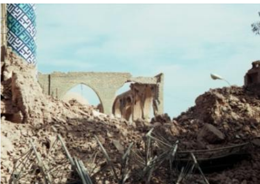
Fig. 81. Äldsta moskén i Bam, Imam Zeid Moskén, kollapsade helt. (IIEES)
