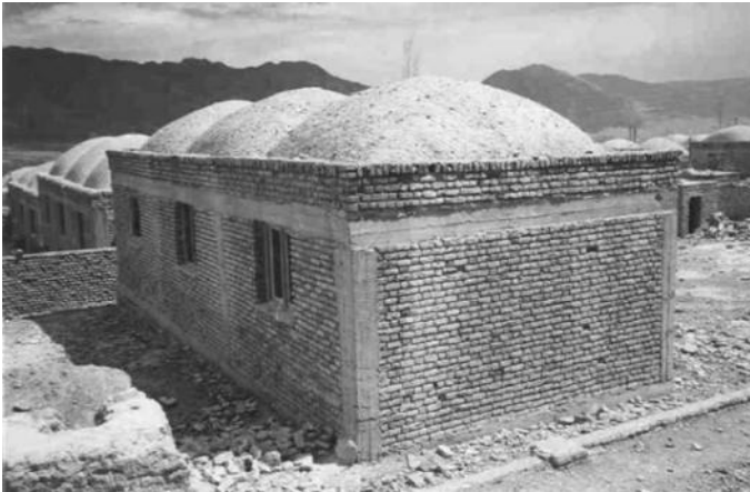
Fig. 116. En av de experimentella byggnaderna i Golbaf efter jordbävningen 1981. Husen är byggda med traditionella tak och med tegelstenar fast med armerade betongband.
