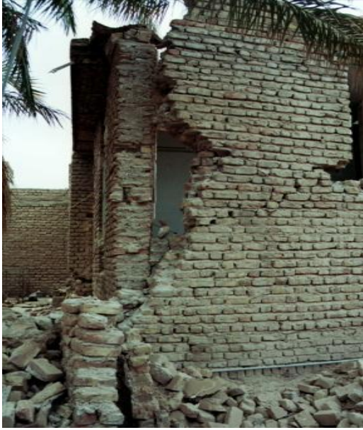
Fig. 45. Dålig förbindning i hörnen samt avsaknaden av vertikala och horisontella band.
