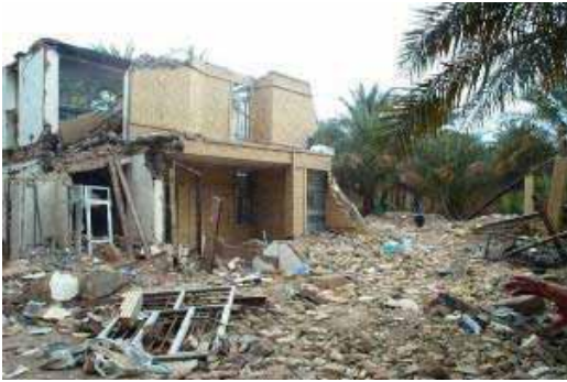
Fig. 42. Studenters sovsal kollapsade under jordbävningen och många av studenterna dog. (Earthquake Engineering Field Investigation Team, EEFIT)
