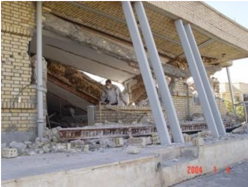
Fig. 66. Takets tyngde skapade för kraftiga tröghetskrafter (IIEES)
