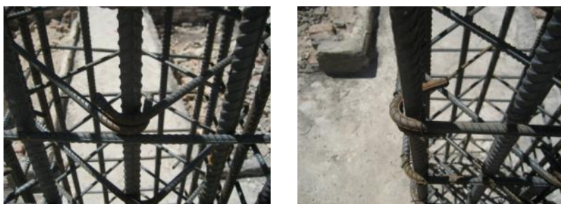
Fig. 143. Felaktigt konstruerade horisontella armeringstänger med för korta krok och dessutom utan 135° krok.
