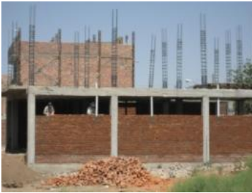
Fig. 135. Horisontella och vertikala band.
