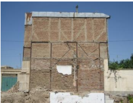
Fig. 129. Ett trevåningshus med galet system av diagonala stödbalkar.
