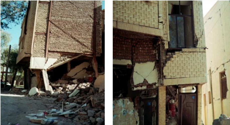
Fig. 53. Första våningen används som ett garage. Många hus i iranska städer har garage på första våningen. I detta fall så har man valt bort diagonala stödbalkar där garagedörren ligger och resulterade i att första våningen agerade som en mjuk våning. Ett annat problem som kan ses i bilden, men som inte orsakade skador på huset, är att i ovanvåningarna så har man valt att använda stålstänger som diagonala stöd trots att iranska byggregler kräver att dessa endast ska byggas med I eller U formade stålpelare. Detta för att pelarens centerlinje ska vara parallell med väggens centerlinje. Stålstänger kan användas till mindre viktiga konstruktioner som murar. Bilden ovan visar vikten av diagonala stöd eftersom väggarna i våningarna ovan klarade sig utan skador. (IIEES)
