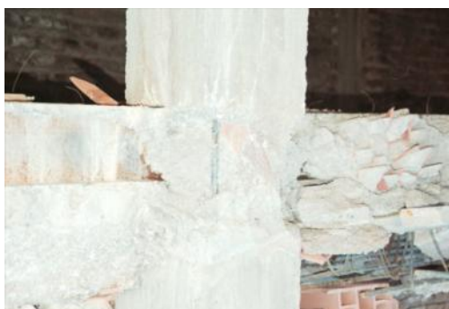
Fig. 59. De allra flesta betonghus brast i förbindningarna. I detta fall så är det en stål balk som penetrerar en pelare. Detta leder till att det inte finns någon plats för horisontella stänger i pelaren just där balken penetrerar; dessa horisontella "bälten" ska binda ihop de vertikala stängerna. Detta är ett systemfel. (IIEES)
