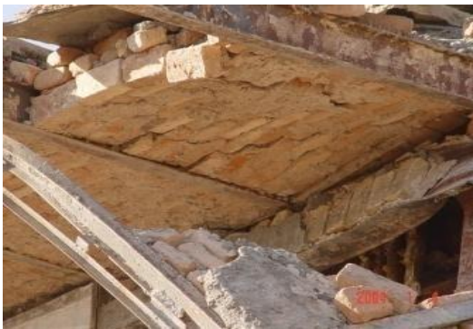
Fig. 35. För stort avstånd mellan stålbalkarna i kombination med ett väldigt tungt valv. Iranska byggregler kräver max 0.9 meters avstånd. (IIEES)
