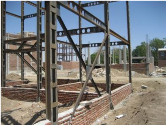
Fig. 134. Ny konstruktion men felaktig anslutning i de diagonala stödbalkarna eftersom centerlinjerna inte är symmetriska. Ett tecken på det behövs ordentliga inspektioner så att denna typ av misstag inte uppstår.
