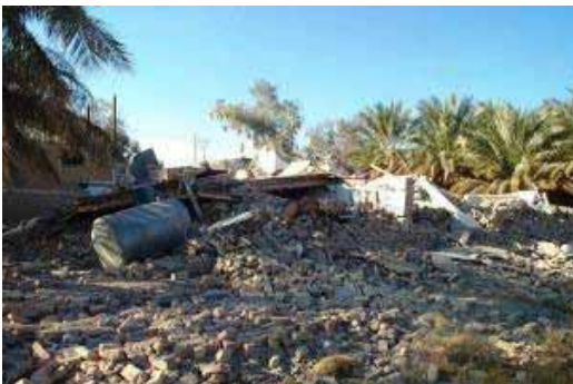
Fig. 44. Kharazami grundskola kollapsade i huvudsak på grund av avsaknaden av horisontella och vertikala band. Även med band så hade denna skola utsatts för allvarliga skador på grund av vattentanken som hade placerats på taket. (IIEES)
