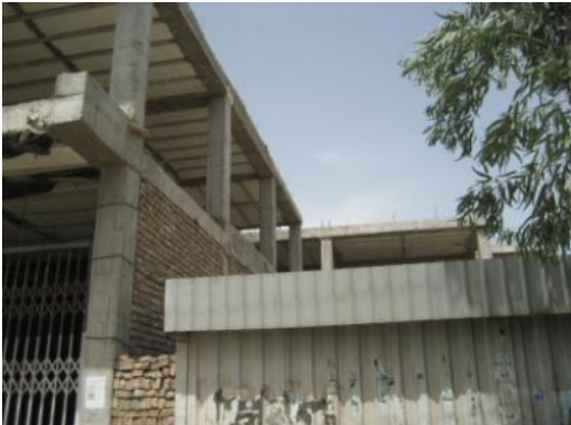
Fig. 112. Ett betonghus i Bam som delats upp för att uppnå symmetri i plan och elevation.
