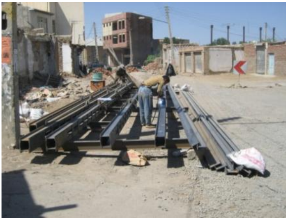
Fig. 132. Fogningen av pelare och balkar sker uteslutande vid byggplatsen och gör det därför svårare att upptäcka eventuella fel.
