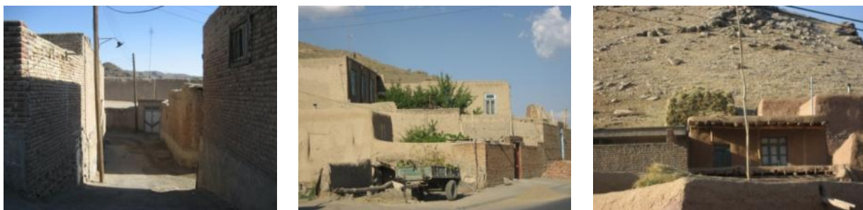
Fig. 137. Liten by någon kilometer från Ajabshir. Inga nya byggnader syntes här. Husen i denna by var gamla och konstruerade med traditionella byggmetoder och med traditionella material.
