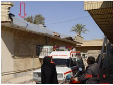
Fig. 69. Ett vanligt problem i Iran är halvväggar på taken och som oftast inte sitter bra ihop med taket. Vid jordbävningar faller dessa ner på gatan. Syftet med väggarna är estetiska samt för att ge skugga på taket.(IIEES)
