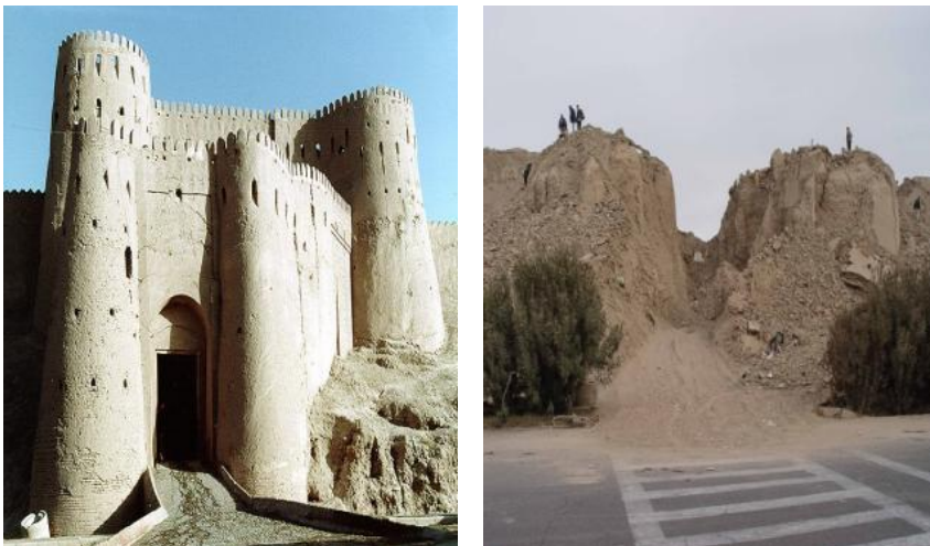
Fig. 90. Före och efter bilder av Arg-e-Bam (IIEES)
