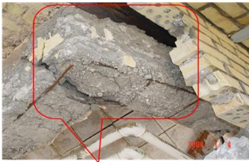
Fig. 67. De longitudinella stängerna skulle bindas ihop med en krok med 90° vinkel i hörnen, men bilden visar att armeringen når precis till hörnen utan någon krok. Dessutom ska stängerna överlappa varandra där de tar slut vid långa balkar. Armeringen skulle överlappa varandra där de möttes.
