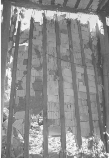
Fig. 36. En platta som kollapsat och hänger löst. ( Performance of Building Roofs in the 2003 Bam, Iran, Earthquake )
