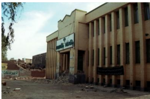
Fig. 85. Entréer till banker utgör ett vanligt problem i Iran. Det är inte ovanligt att banker i efterhand bygger ut nya entréer och ansluter det med resten av byggnaden. Problemet är att byggnaden då får en osymmetrisk form och komplicerade vridmoment uppstår vid dessa utbyggnader. Entrén ska istället konstrueras som en byggnad för sig och inte direkt byggas ihop med huvudbyggnaden, detta för att hindra överföring av tröghetskrafter från huvudbyggnaden till entrén och tvärtom. (IIEES)
