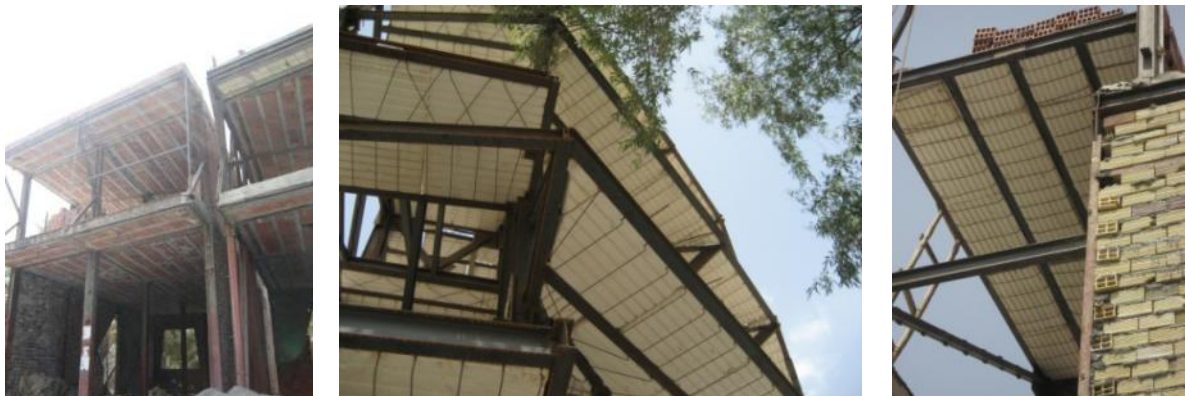
Fig. 110. Numera använder man sig mera av betong, stål och håltegel och samtliga nybyggda hus i Bam har horisontella och vertikala band. En av de största skillnaderna är att iranska byggare idag bygger lätta golv av antingen armerad håltegel eller frigolit med flytbetong på. De tunga golven och taken har utgjort det allvarligaste hotet mot byggnaderna, och reduceringen av vikten för golv och tak har stor betydelse för byggnadens beteende under en jordbävning. Frigolitgolven är idag det mest utbredda i Iran. Bilderna ovan är tagna i Bam.
