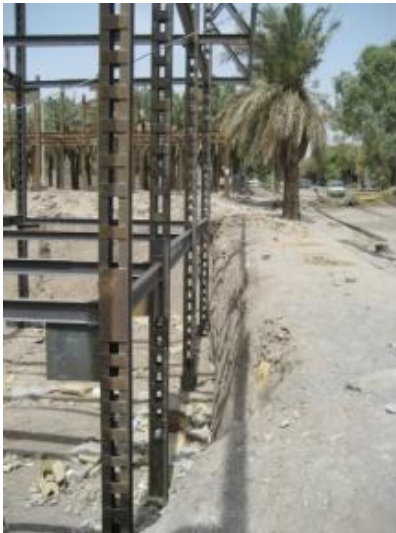
Fig. 58. Korrekt placerade plattor på pelaren
