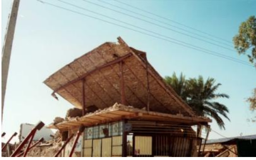
Fig. 50. Bra byggt golv där balkarna inte lossade från varandra men väggarna saknade diagonala stödbalkar i väggarna (bracing på engelska). Stålpelarna kollapsade av vridmomenten. (IIEES)
