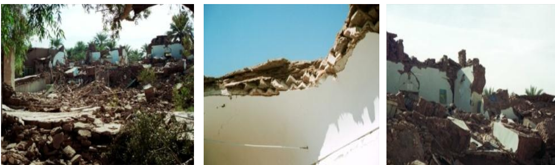
Fig. 73. Skolor med platta och tunga tak samt med tjocka väggar. (EEFIT)
