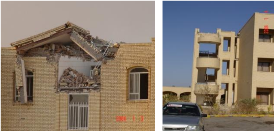
Fig. 48. Många av trapphusen kollapsade. Trapphuset måste betraktas som ett hus för sig och byggas så att tröghetskrafterna kan överföras på ett säkert sätt till våningen under. De allra flesta trapphus byggs ihop med resten av huset med dåliga förbindningar, vilket leder till osymmetri i vikten och i elevation vilket medför skadliga vridmoment. (IIEES)
