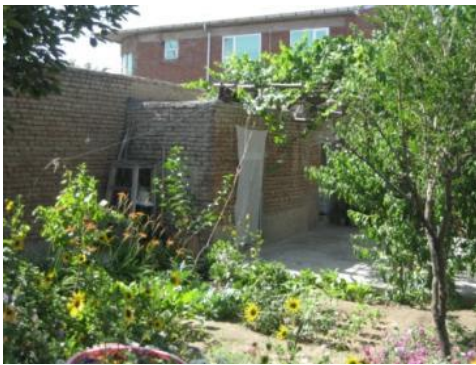
Fig. 125. Utetoalett utan band. Toaletter på gårdar måste numera förses med band.
