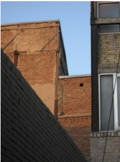
Fig. 122. Ett annat hus med en pelare som plötsligt tar slut och ersätts av en träpelare. Man har valt att bygga vidare på höjden.
