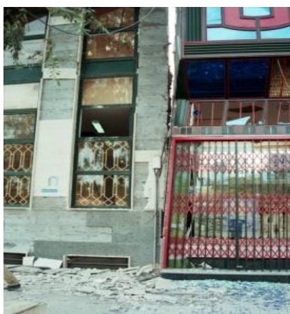
Fig. 84. Fasadplattor som släppt. Fasadplattor ska egentligen ha spår på baksidan för att få bra fäste i murbruket. När det gäller större plattor så ska de även ha diagonala ståltrådar, som fungerar som armering. Dessa plattor, som även installeras inomhus, utgör en stor fara när de faller ner från väggen. (IIEES)
