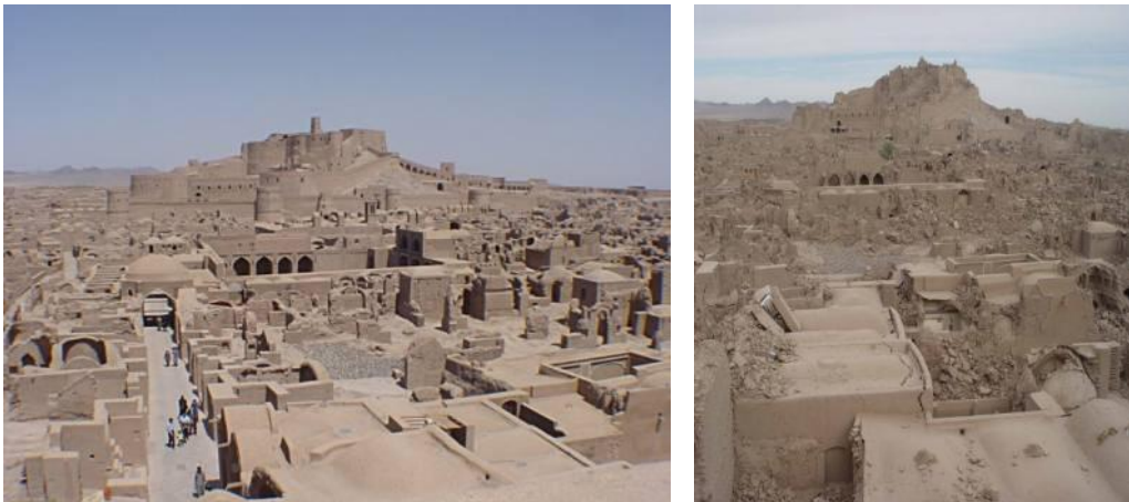
Fig. 89. Före och efter bilder av Arg-e-Bam (IIEES)
