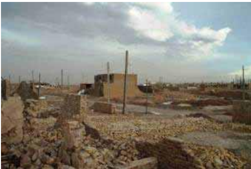
Fig. 43. Samtliga kollapsade hus i denna bild saknade jordbävningresistenta band. Byggnaden som ensamt står kvar var det enda i kvarteret som hade band och visar vikten av dessa horisontella och vertikala band. (EEFIT)
