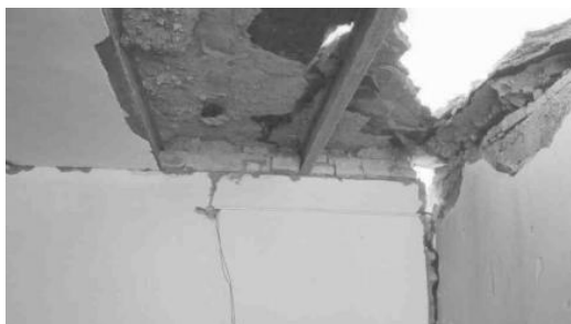
Fig. 33. I detta fall så har byggarna valt att ta bort den yttersta balken. (Performance of Building Roofs in the 2003 Bam, Iran, Earthquake)
