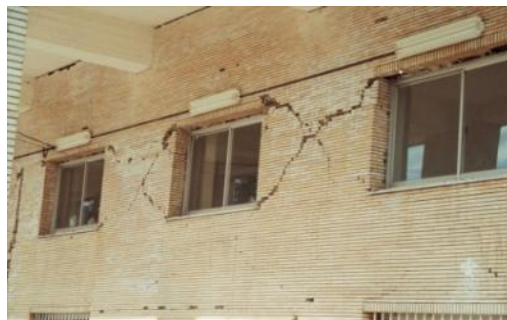
Fig. 13. X-sprickor uppstår mellan öppningar som är för nära varandra och det samtidigt saknas horisontella band ovanför dessa öppningar. (IAEE och IIEES)
