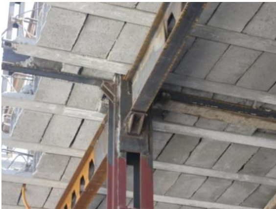
Fig. 133. Bra anslutning mellan pelare och balk.
