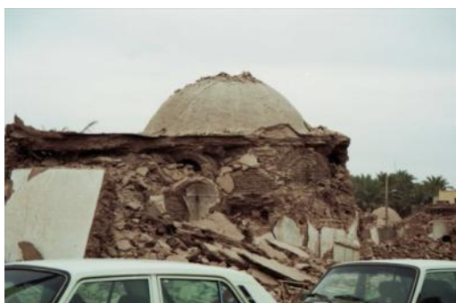
Fig. 28. Kupoltaken klarade sig bättre än både cylinderformade tak och platta tak. (IIEES)
