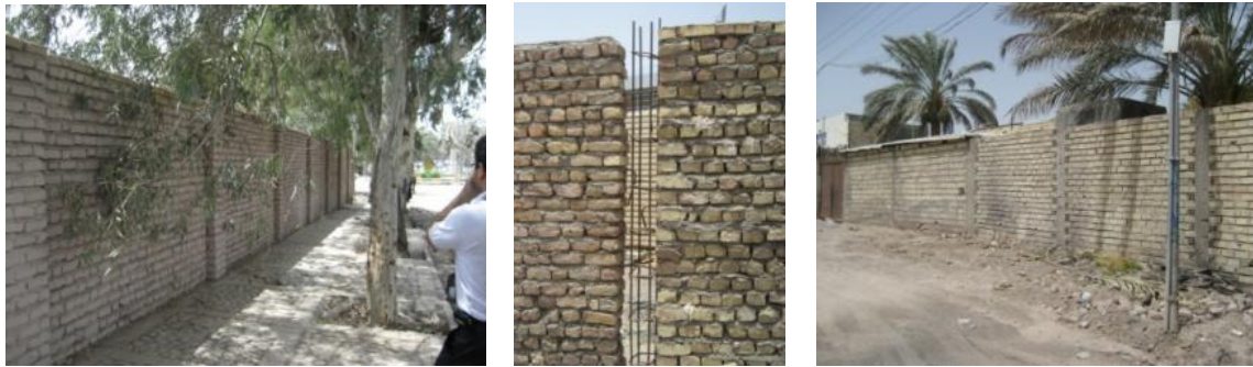
Fig. 114. Långa murar delas in i mindre partier.
