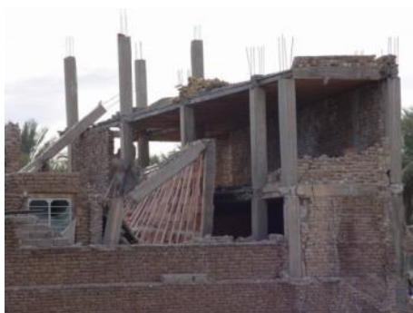
Fig. 59. De allra flesta betonghus brast i förbindningarna. I detta fall så är det en stål balk som penetrerar en pelare. Detta leder till att det inte finns någon plats för horisontella stänger i pelaren just där balken penetrerar; dessa horisontella "bälten" ska binda ihop de vertikala stängerna. Detta är ett systemfel. (IIEES)
