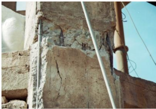
Fig. 62. Armeringsstänger som är för nära kanten och som dessutom är ogängad. (IIEES)
