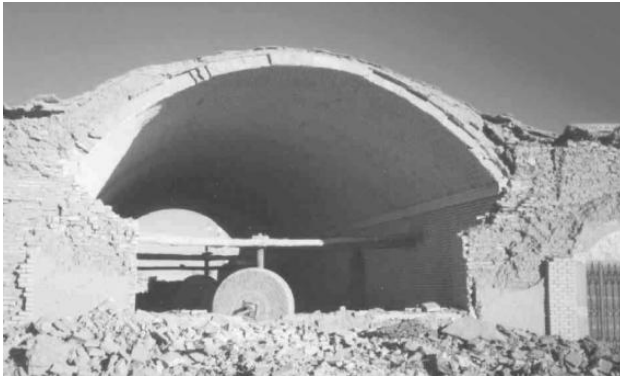
Fig. 31. Gammal fabrik i Bam. Ett av de bättre cylinderformade valvtaken som klarade sig. De bärande väggarna fick stöd dels genom de invändiga träbalkarna som binder ihop väggarna och dels genom stöd från intilliggande byggnader på båda sidor om fabriken. (Performance of Building Roofs in the 2003 Bam, Iran, Earthquake och IIEES)
