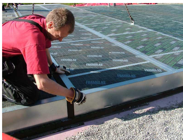
Bild 7.3 Grundläggning med Koljerntekniken (MRD Sälj och Bygg AB u.d.)
