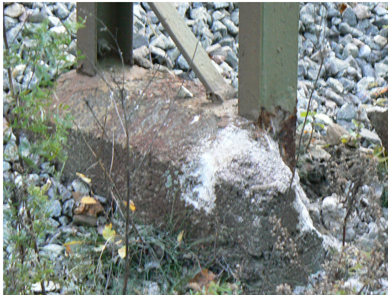
Figur 4.8 Fundamenttoppen under pågående bilningsarbete
