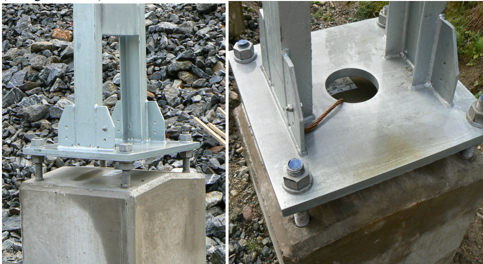
Figur 2.4 Nedre del av kontaktledningsstolpe med fotplatta samt anslutning till prefabricerat betongfundament från sidan respektive ovanifrån. Fotografier tagna längs med tågsträckningen Västra Hanninge-Nynäshamn
