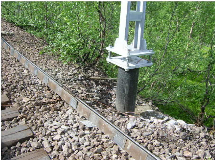
Figur 2.8 Kompletterat installerat BVI-3.1-fundament utmed sträckan Kiruna-Riksgränsen (Stenman 2005, s.16)
