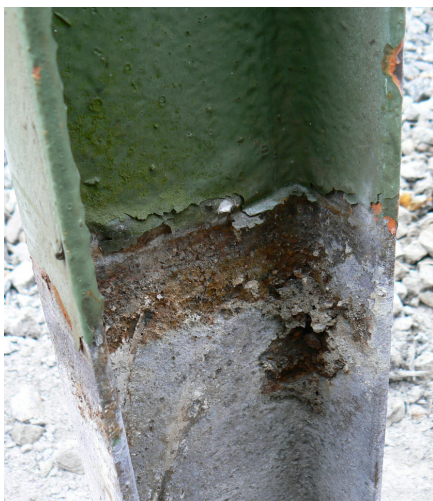
Figur 4.18 Korrosion på balktvärsnitt i det område som anslutit till fundamenttoppens ovansida
