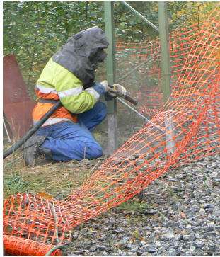
Figur 3.3 Blästring på kontaktledningsstolpe längs med Saltsjöbanan, Stockholm
