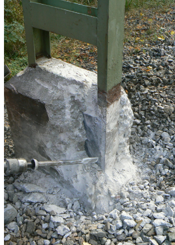
Figur 4.2 Nedbilning av fundamenttopp
