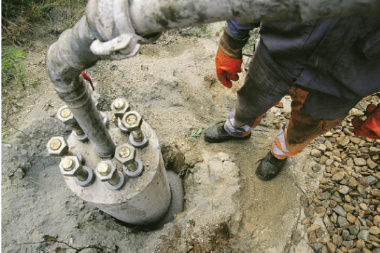
Figur 2.13 Gjutning av injekteringsrör och kringjutning av fundament (Stenman 2005, s.22)
