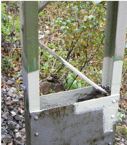
Figur 4.13 Frilagt gods efter att detta målats med primer. Särskilt på det högra balktvärsnittet kan en otydlig rostrand ses nära stabiliserande plåt
