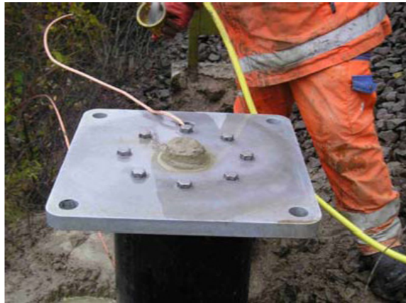
Figur 2.10 Fundamentets fästplatta. I mitten av fästplattan kan den betong som trycks upp genom fundamentets kopplingshål ses (Stenman 2005, s.13)
