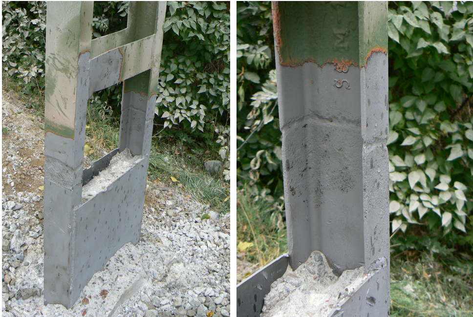
Figur 4.3 Tydlig rostband efter blästring
