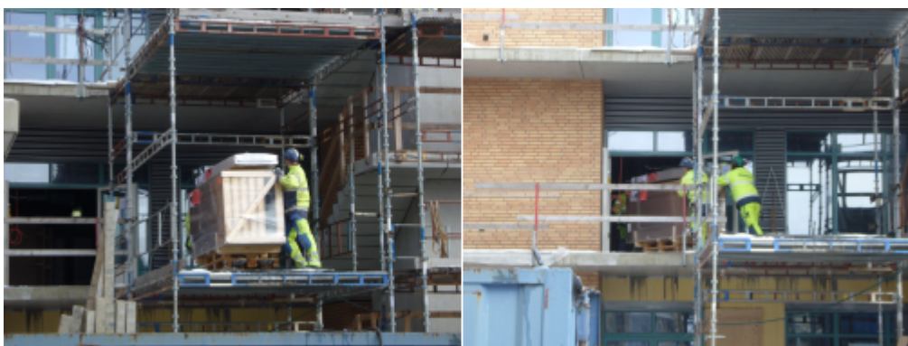
Figur 48. Inlastningsprocess, Kvarteret Astern
