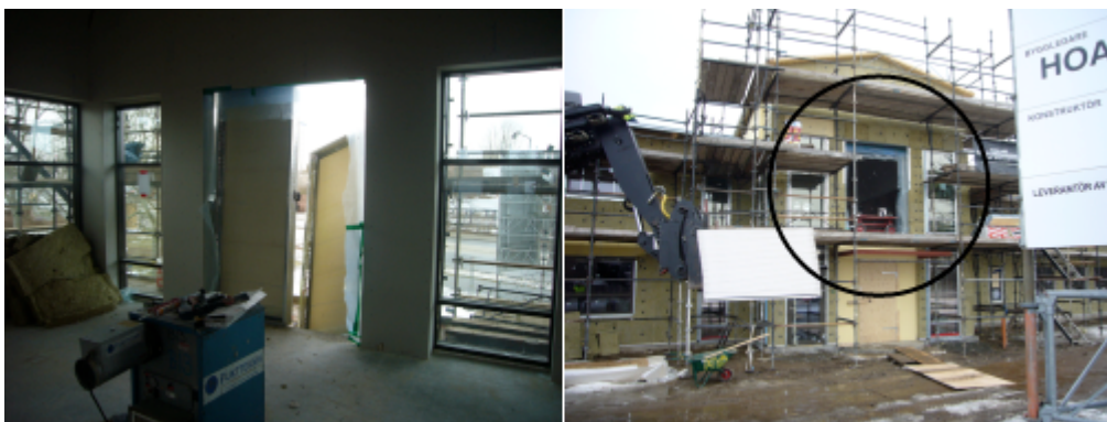
Figur 53. Avtagning av provisorisk vägg
