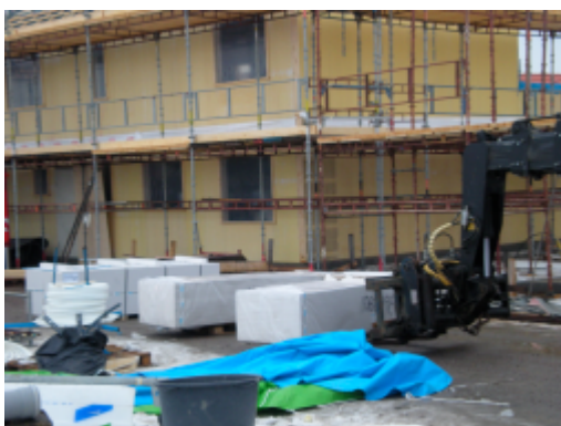
Figur 41. Avlastning av gipsskivor
