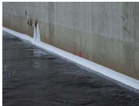
Figur 8 – Närbild på väggen.
