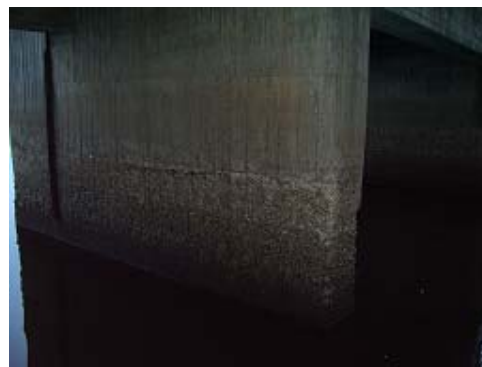
Figur 4 – Skador på pelaren.
