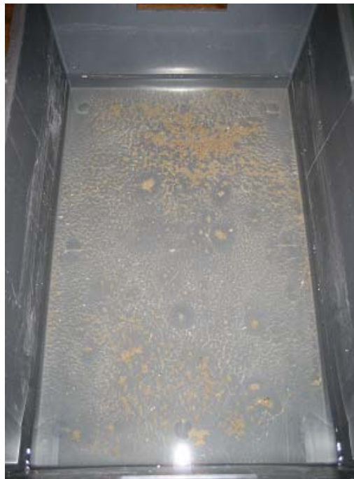
Figur 38 – Avskalad betong i plastbalja.
