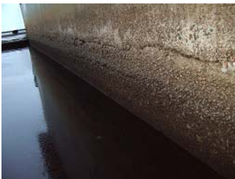
Figur 3 – Skador på väggen.
