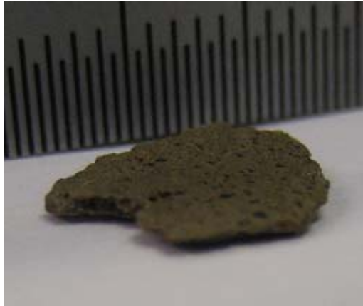
Figur 39 – Avskalad flarn av betong.
