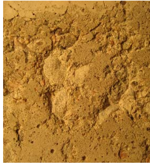
Figur 37 – Närbild på avskalning.
