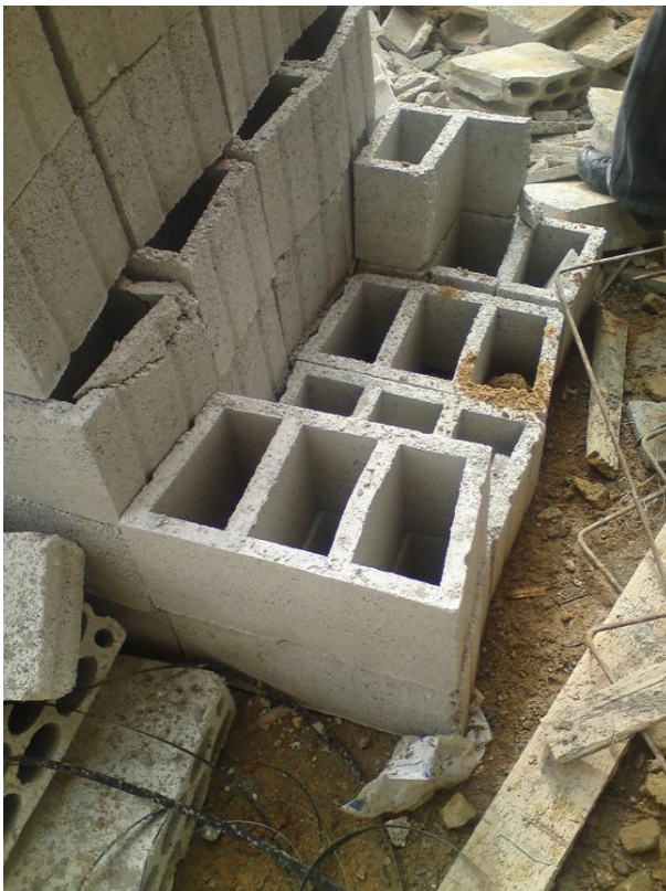
Figur 5.7 Betonghålblock för tak
