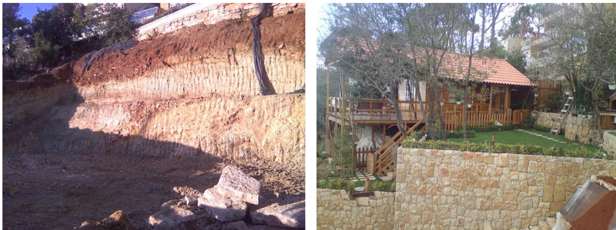
Figur 5.8 – 5.9 uppgrävning av sten som sedan används som dekoration
