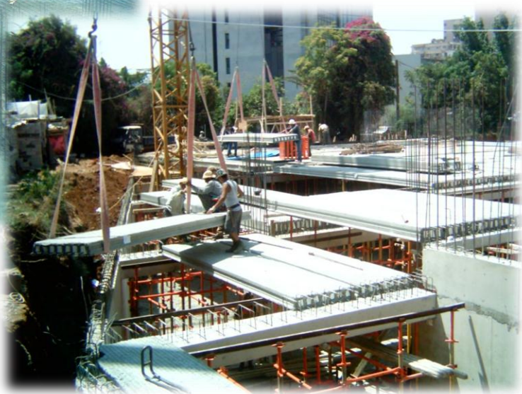
Figur 5.2 Prefabricerad betong monteras på plats
