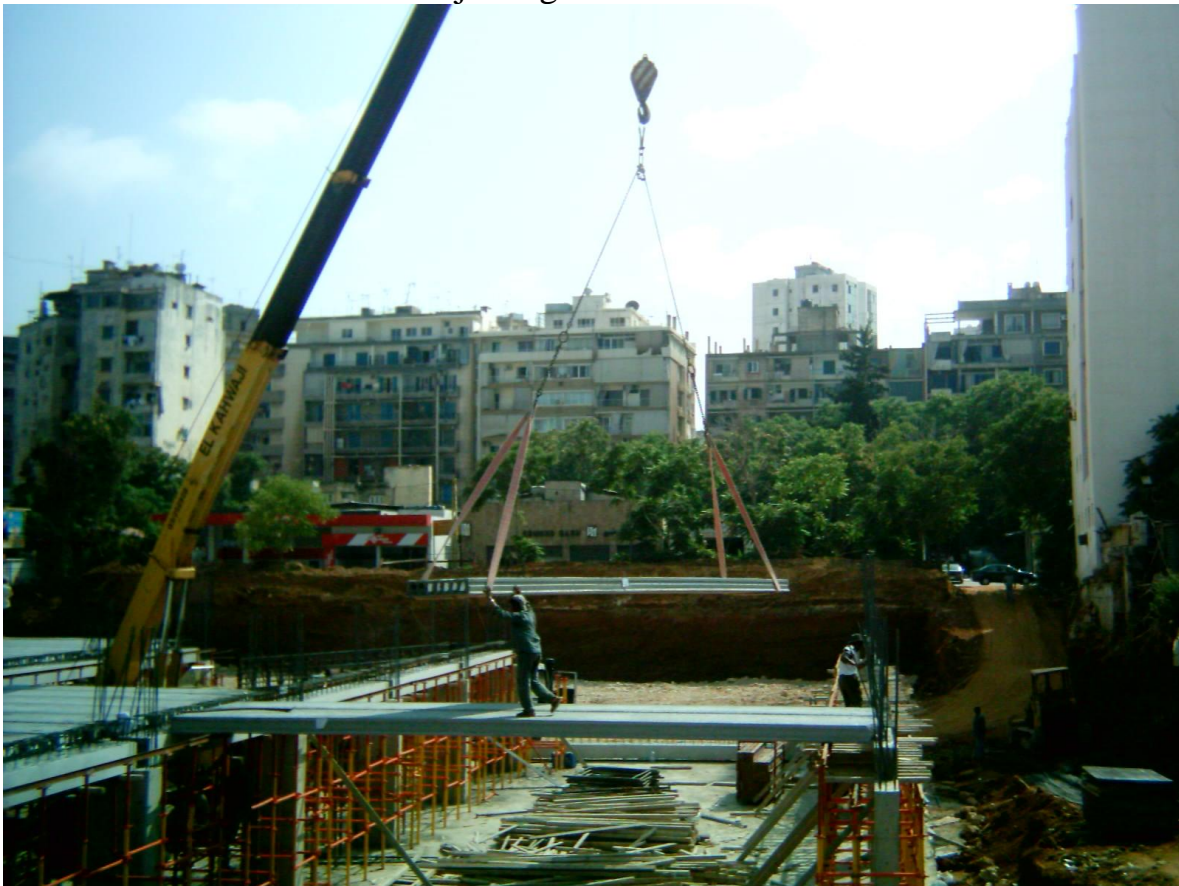
Figur 5.20 Prefabricerad bjälklag monteras på plats
