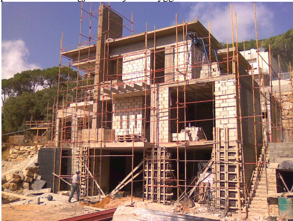
Figur 5.26 Ytterväggarna är färdig murade
