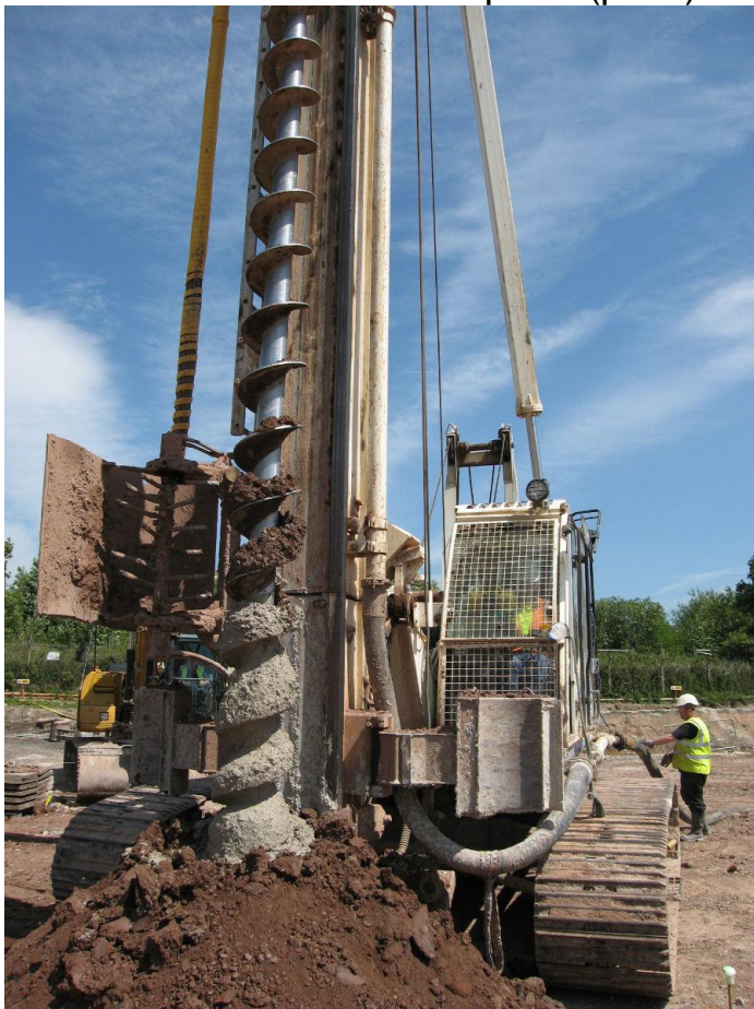
Figur 5.11 Ett exempel på en hydraulisk roterande bormaskin
