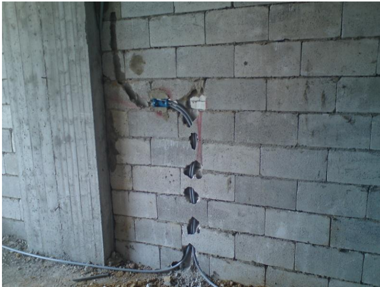
Figur 5.6 Installationen i betonghålblock
