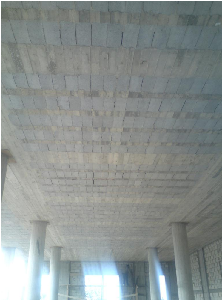
Figur 5.22 Färdig gjutet bjälklag
