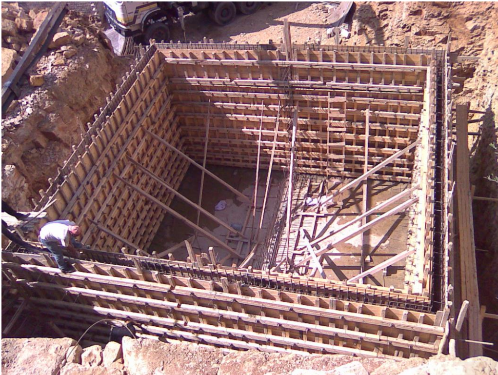
Figur 5.17 Gjutning av källarväggar
