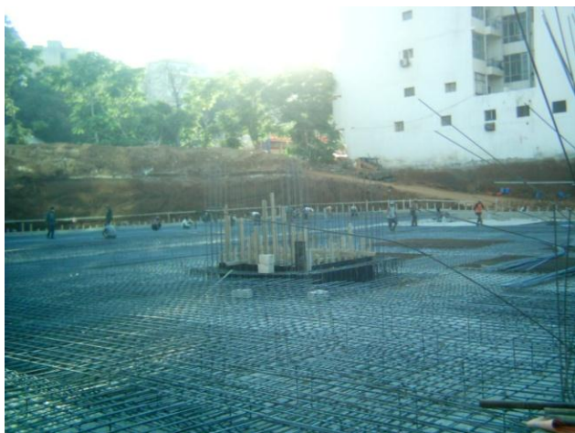
Figur 5.15 Armering av plattan och pelarna
