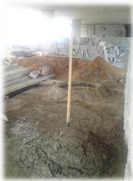
Figur 5.32 Egengjord cementmurbruk
