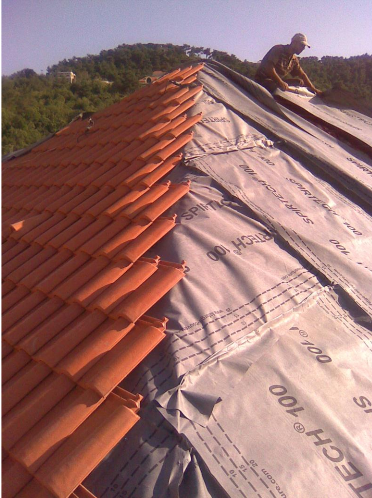
Figur 5.29 Läggnig av takpannor
