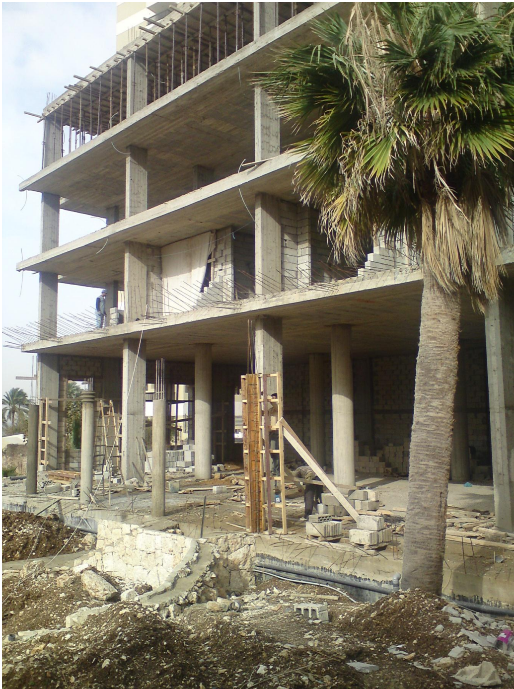
Figur 5.23 Murning i samband med gjutning av andra bjälklag
