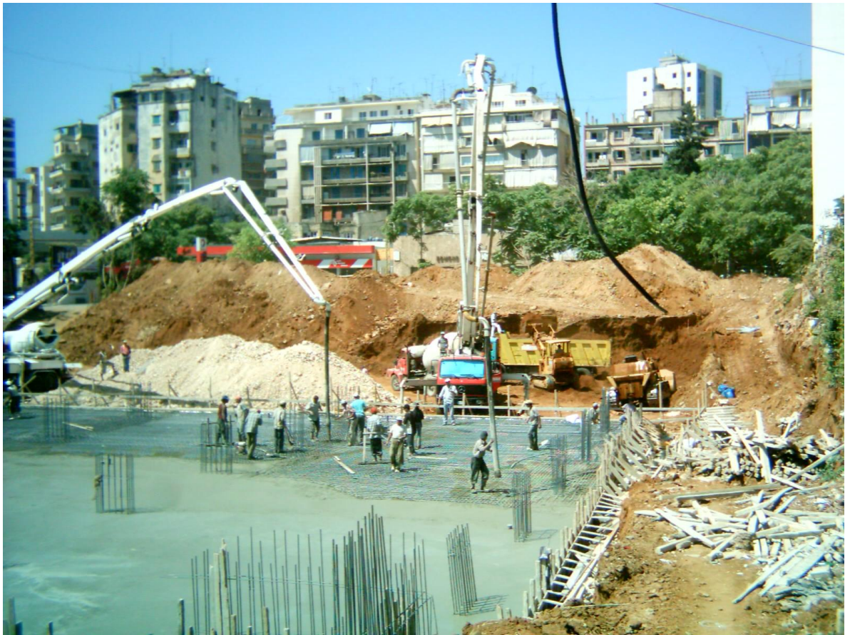
Figur 5.16 Gjutning av platta på mark
