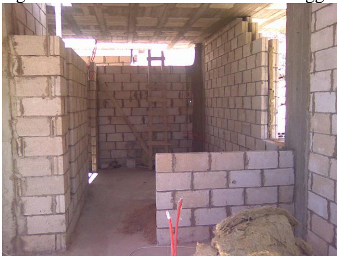
Figur 5.27 Sandwich vägg med betonghålbsten
