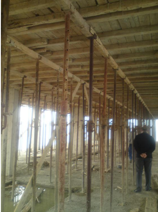
Figur 5.21 Förberedelse inför bjälklaget
