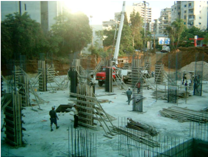
Figur 5.18 Pelarna armeras och förbereds för gjutningen
