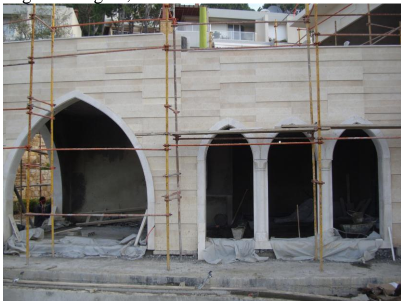
Figur 5.10 Ett exempel på användning av konst stenar på en villa utanför Beirut
