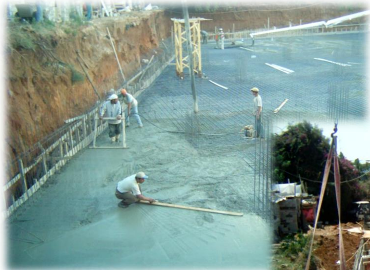
Figur 5.1 Gjutning av betong på plats
