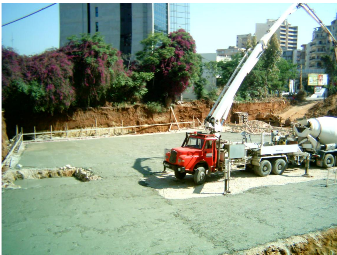
Figur 5.14 gjutning av "betong support"
