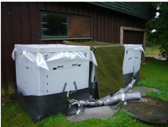
Figur 5. En vanlig modell av en növvattentank. Här är tanken inkopplad till ett hushålls vanliga vattenledningssystem.
