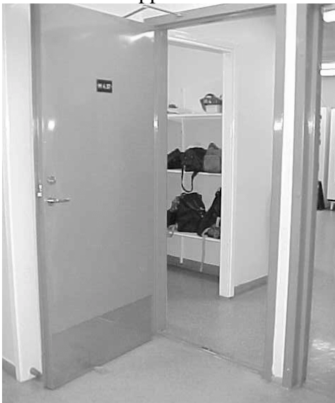
Bild B8.3. Uppställd branddörr på plan 1 i A/B-byggnaden.
