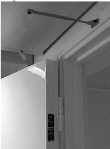
Bild 3.5. Dörrstängare på dörr in till rum P4.018.
