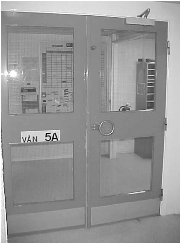
Bild B8.2. Skev branddör på plan 6 i A/B-byggnaden.
