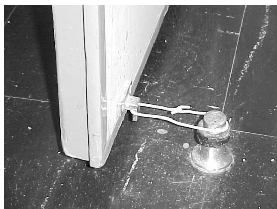
Bild 3.1 och 3.2. Uppställd branddörr på plan 5 i A-byggnaden.
