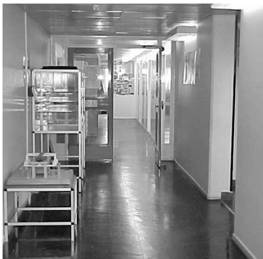
Bild 3.1 och 3.2. Uppställd branddörr på plan 5 i A-byggnaden.
