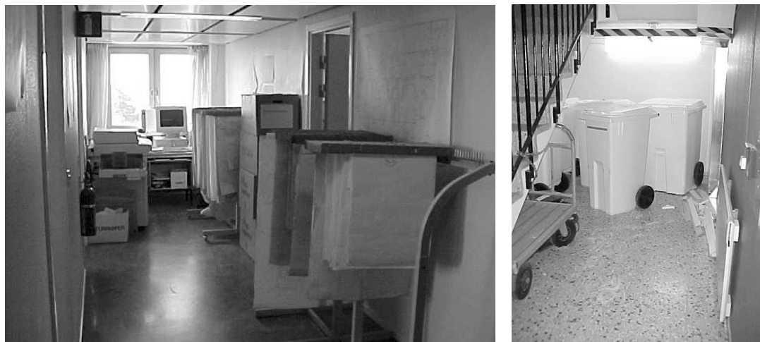
Bild 3.8 och 3.9. Nordvästra korridorsslutet på plan 5 i P-byggnaden. Skräp längst ned i trapphus i A/B-byggnaden (M4.104).
