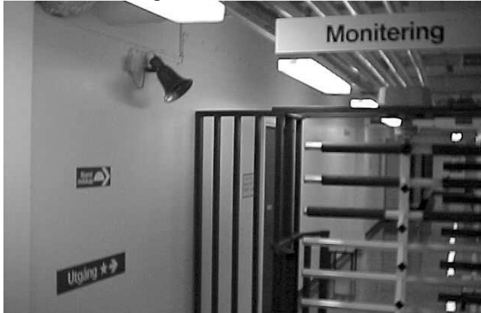
Bild 3.10. Grind som är skyltad som utgång trots att den saknar nödöppningsprint (rum P2.051).
