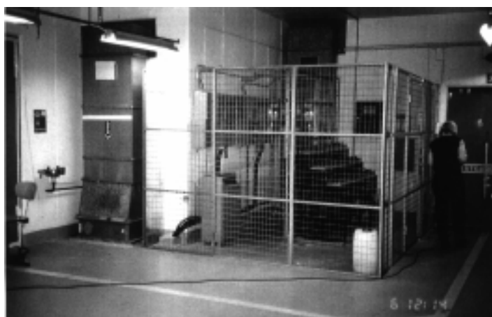
Figur 5.3 Rum 3 E 3-03. Till vänster syns den vertikala tilluftskanalen.
