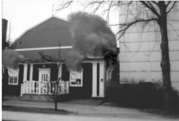
Figur 5.4: Branden har brutit igenom yttertaket
