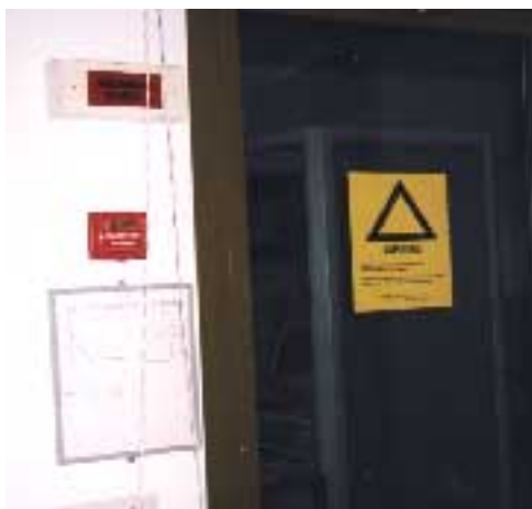
Figur 5.2 Halonanläggning som påträffades vid brandsyn i Malmö. Halon är förbjudet som släckmedel i Sverige sedan den 1 januari 1998. Brandsyneförrättaren är skyldig att meddela berörd myndighet.
