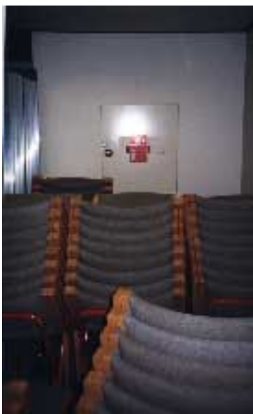
Figur 7.14 Blockerad "slangevinde" (brandpost) (vänster), blockerad "slangevinde" (mitten), blockerad utrymningsväg. Lägga märke till spärren i golvnivå (höger).
