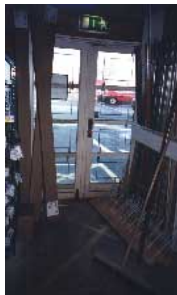
Figur 7.14 Blockerad "slangevinde" (brandpost) (vänster), blockerad "slangevinde" (mitten), blockerad utrymningsväg. Lägga märke till spärren i golvnivå (höger).
