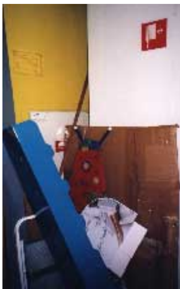
Figur 7.14 Blockerad "slangevinde" (brandpost) (vänster), blockerad "slangevinde" (mitten), blockerad utrymningsväg. Lägga märke till spärren i golvnivå (höger).
