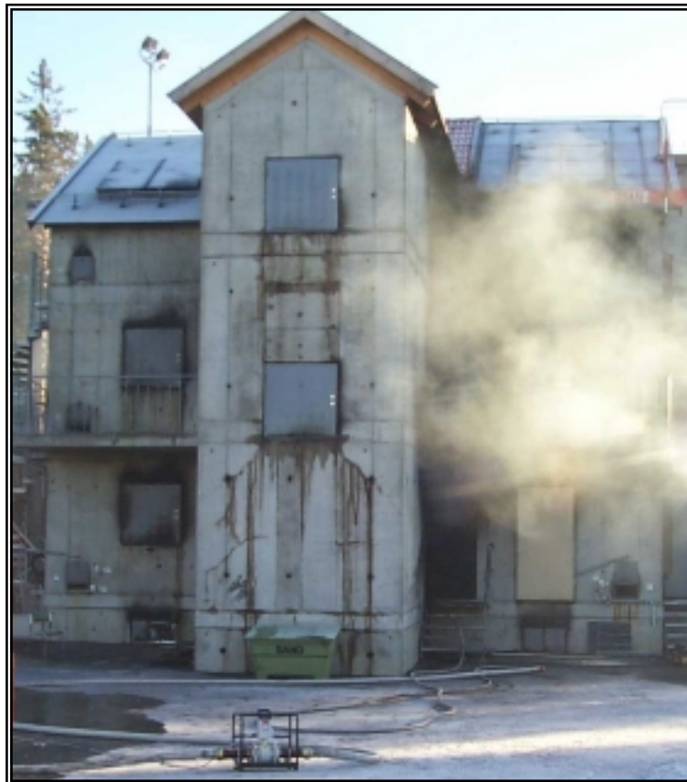
Bild 3. Nordvästra fasaden på brandövningshuset.
