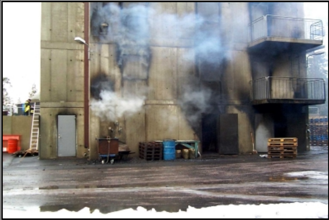
Bild 2. Nordöstra fasaden på brandövningshuset.
