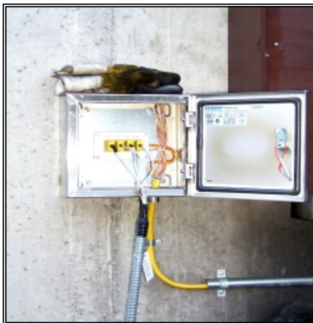
Bild 13. Kopplingsdosan och de fyra kontaktorna till givarna.
