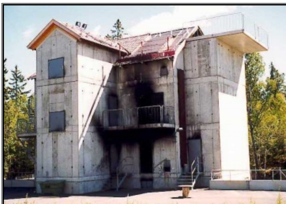
Bild 1. Nordvästra fasaden på brandövningshuset.
