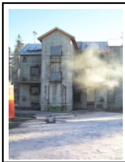
Bild 6.5: Ågesta brandövningshus sett från framsidan. Notera att källarplanet inte syns från denna sida.
