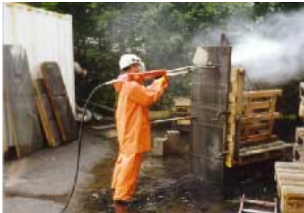
Bild 4.1 Skärförsök i sandwichkonstruktion.
