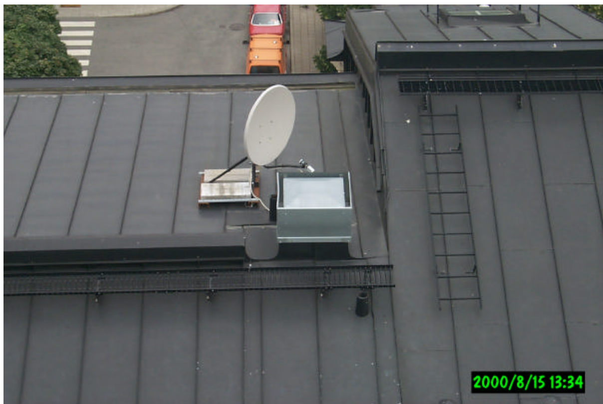
Bild 15.1; Takhuv för gemensam brandgasavluftning för hus D
