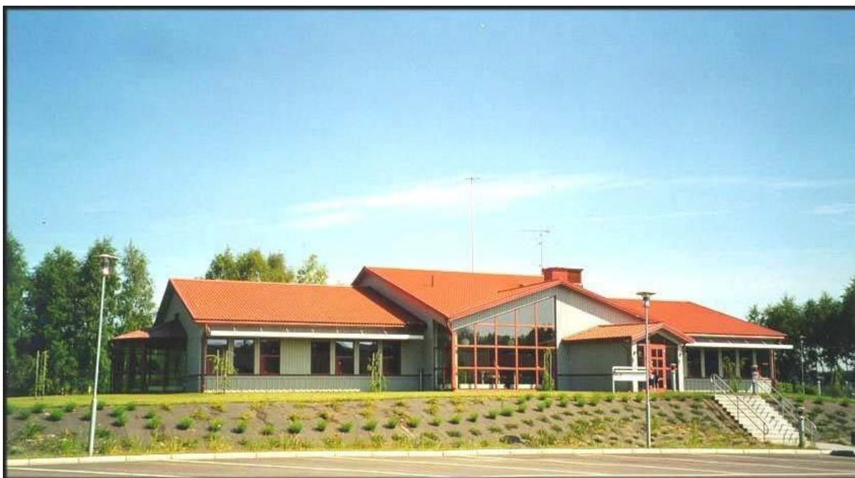
Bild 2.1 Taktik- och ledningscentralen, TLC, vid Räddningsverkets skola Skövde
