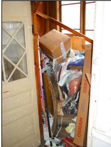
Figur 4.10.1 Genomgående trapphus som uppenbarligen används som förvaringsutrymme. Förutom mycket löst brännbart material består väggar och tak i trapphuset av träfiberskivor.
