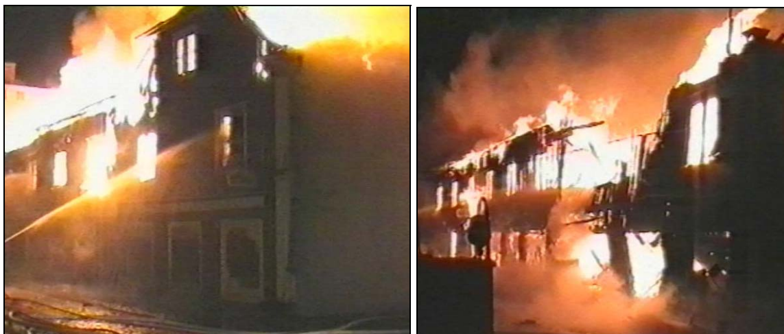
Figur 6.4.1 Bilden till vänster visar en brinnande byggnad då branden spridits ner genom vindsbjälklaget. Bilden till höger visar samma byggnad då branden är i avsvalningsfasen. Ytterväggen kommer strax att falla ihop. Bilderna är hämtade från /40/.
