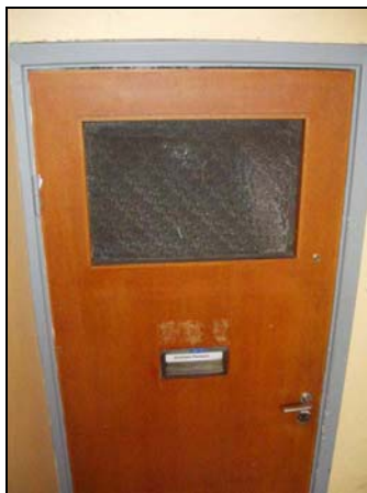
Figur 4.9.1 Lägenhetsdörr med glasparti utan brandteknisk klass.
