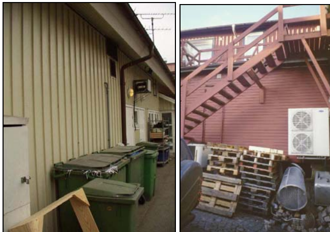
Figur 4.15.1 Bilden till vänster visar sopkärl som förvaras mot träfasad. Bilden till höger visar att brännbart material ofta förvaras nära träfasader. Trätrappan är enda vägen till och från lägenheterna som skymtar i ovankanten.
