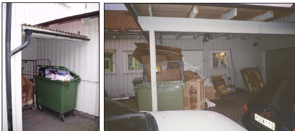
Figur 3.2.3 Bilderna visar hur sopkärl, emballage och lastpallar förvaras nära träväggar och dessutom under trätak.
