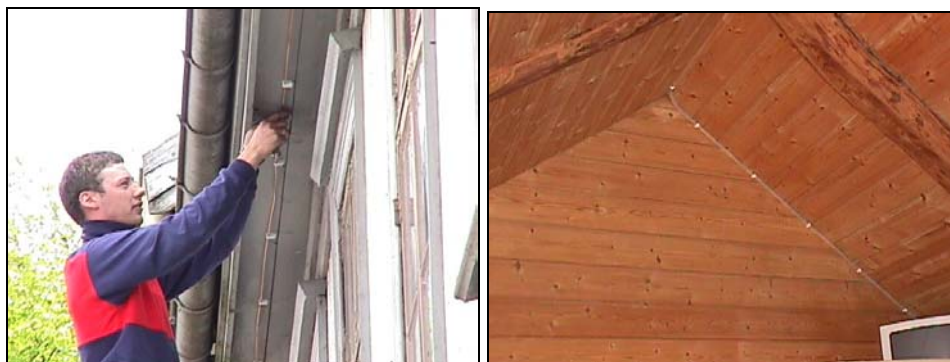
Figur 5.3.3 Bilden till vänster visar hur det värmedetekterande röret monteras i takfoten. Bilden till höger visar hur det värmedetekterande röret placerats i ett vindsutrymme. Bilderna är tagna av /38/.
