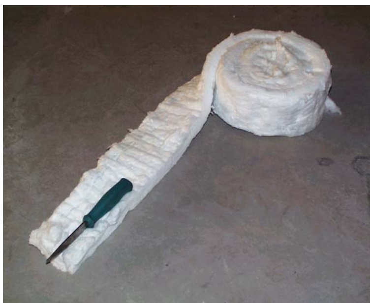
Bild A2.5 Den keramiska isoleringen delas till remsor i lämplig bredd med hjälp av kniv.
