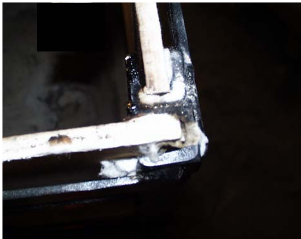
Bild 4.18 Hörn med två U-profiler i vilka respektive väggskiva ställs. Kortsidan går uppåt i bilden
