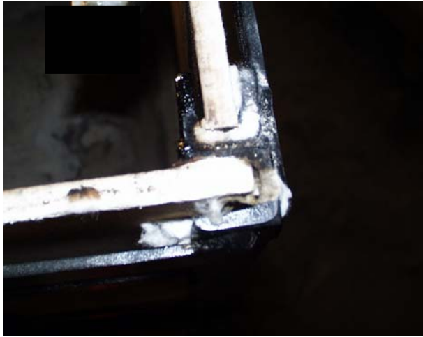
Bild 4.6 Hörn med två U-profiler i vilka respektive väggskiva ställs. Kortsidan går uppåt i bilden
