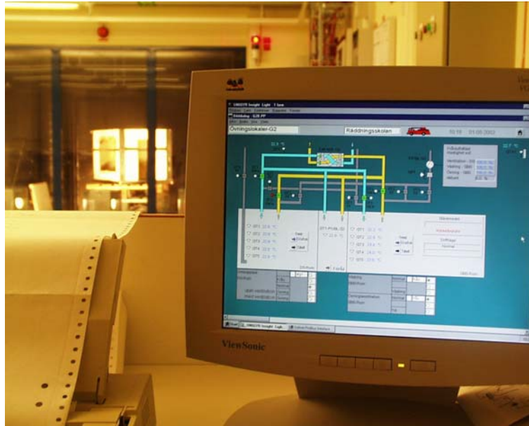
Bild 2.4 Längst fram i lektionssalen finns datorn som styr ventilationen. På skärmen syns flödesschemat för ventilationen i detektor- material- och förevisningsrummet.
