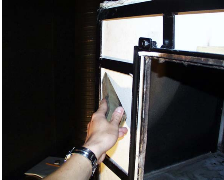
Bild 4.21 Komplettering av drevning måste göras i U-profilerna.
