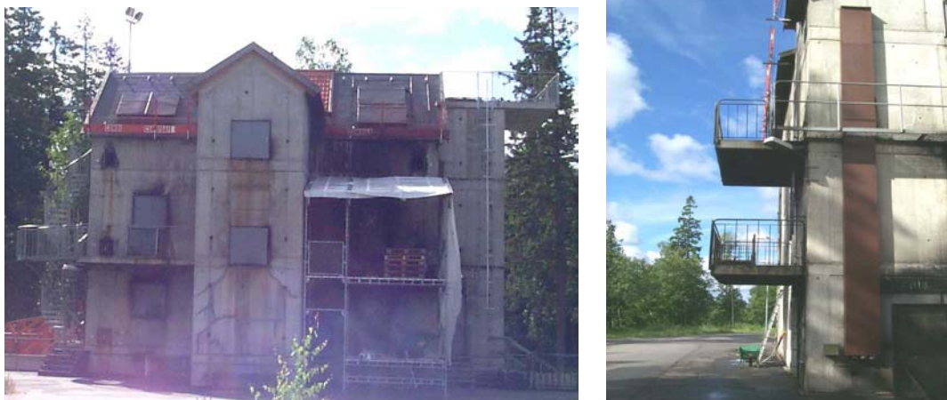
Bild 1. Brandsläckningshuset från två vinklar
