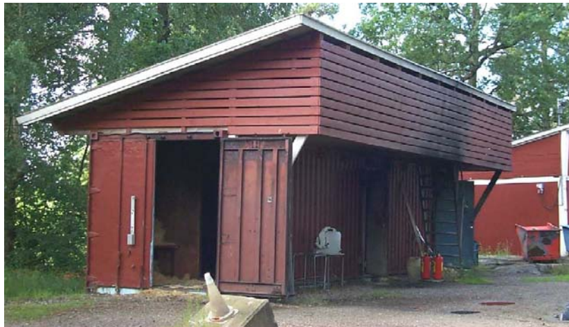
Bild 9. Ombyggd container för extern och intern övning
