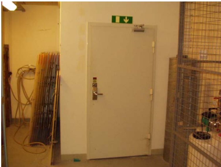
Bild 5. Utrymningsdörr med enbart elektriskt kodlås
