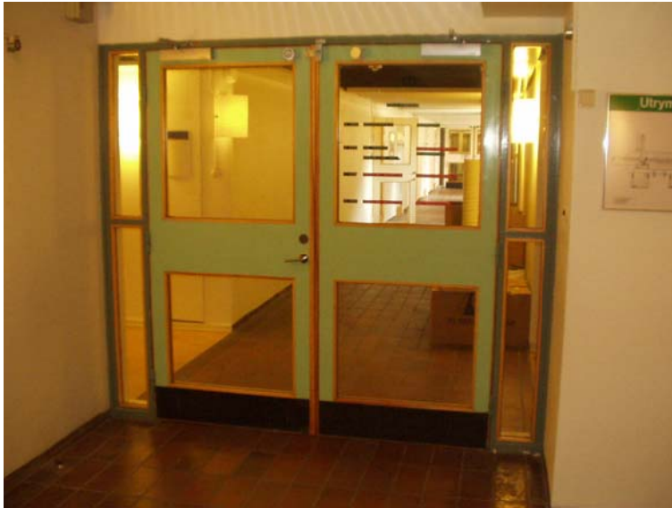
Bild 1. Dörr i brandcellsgräns med glaspartier.
