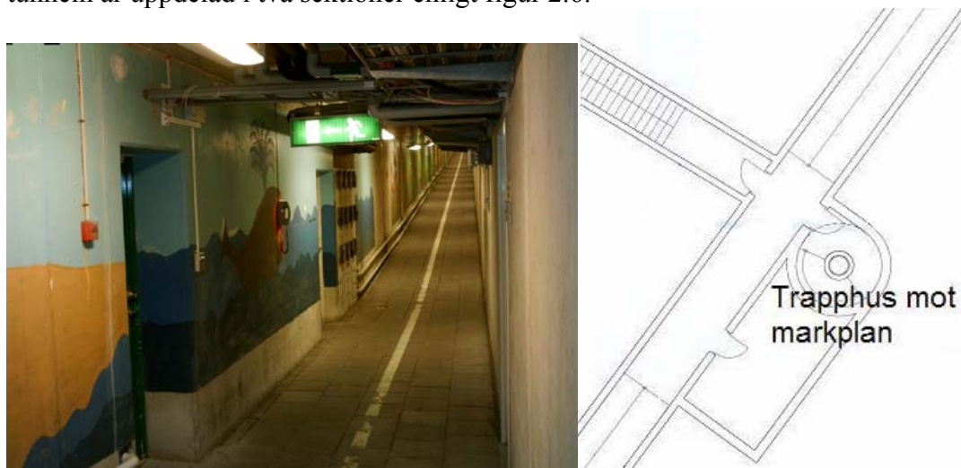
Figur 2.7 T.v. sedd från nordöstra anläggningen, visar den lägsta punkten av gångtunneln ca 6 m under mark. T.h. Nödutgången som går till en spiraltrappa som leder upp ovan mark.
