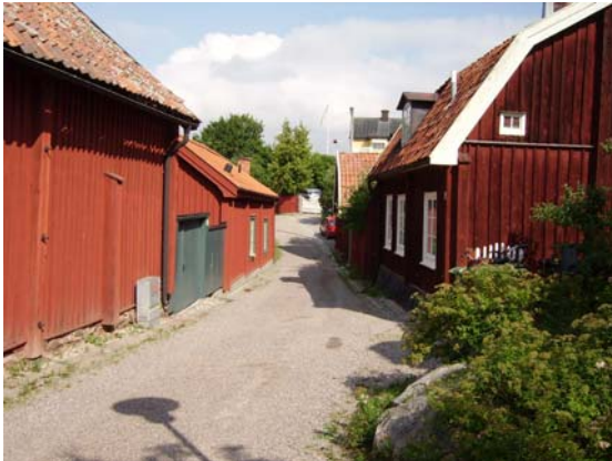
Figur 5.6 – Bergsgatan. Tomterna Kungshusen 10 och 1 till vänster och Båtsmansberget 15 till höger.
