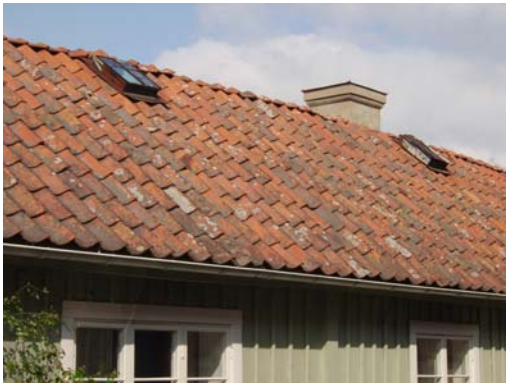
Figur 5.26 – Takluckorna på tomt nummer 2 är ej utförda i brandklass och taket kan således inte förväntas stå emot en brand.
