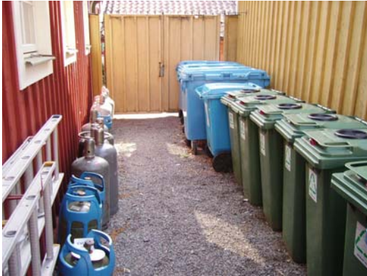
Figur 5.17 – Sophantering och tömda gasflaskor mot fasaderna mellan byggnad 2 och 5.
