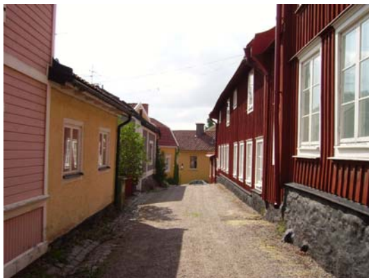
Figur 7.4 – Krukmakaregränd. Sprinklersystemet monteras i takfoten på kv. Kadettens bostadslänga (till höger i bild).
