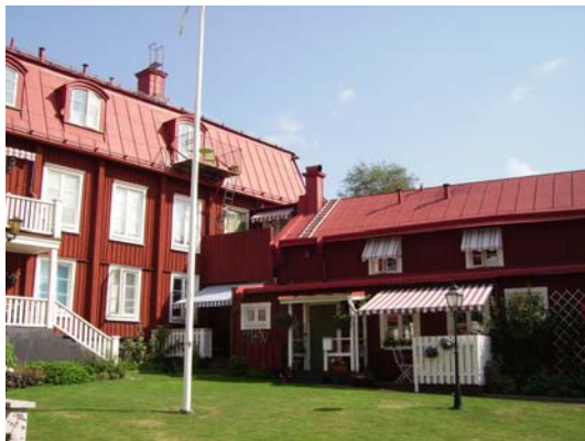
Figur 5.12 – Kv. Kadettens nordöstra hörn, sett från innergården.
