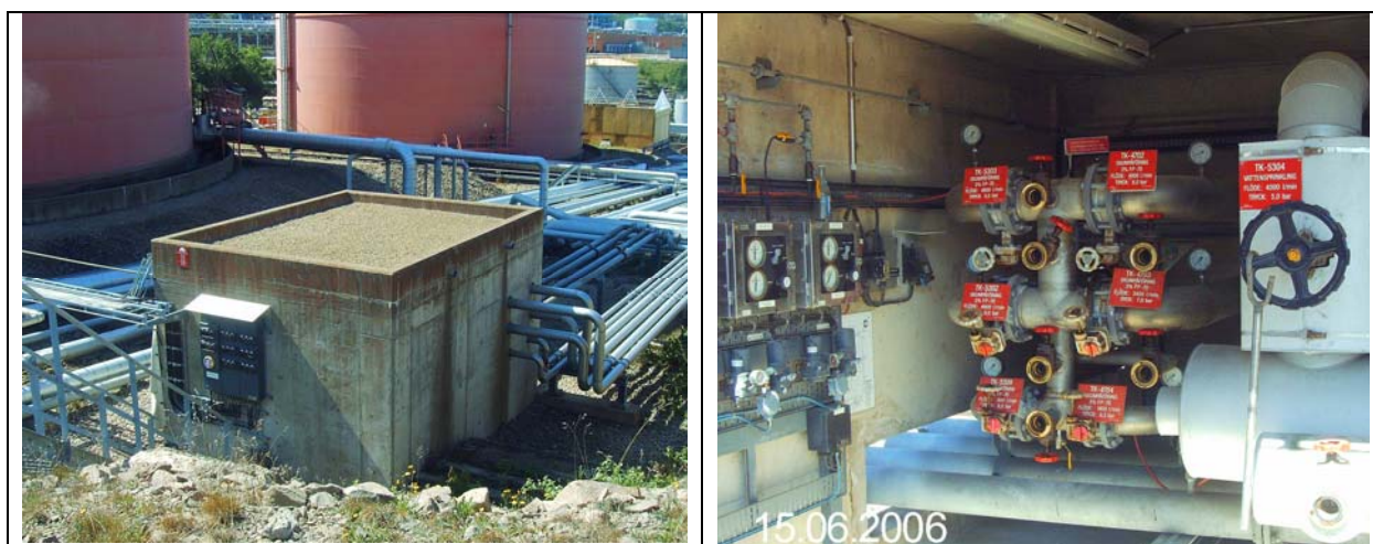
Figur 3:3 Bunkern med påföringskopplingar 47
