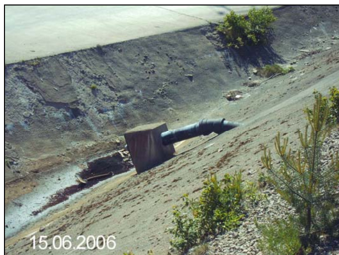
Figur 3:2 Rör för nöddumpning 46
