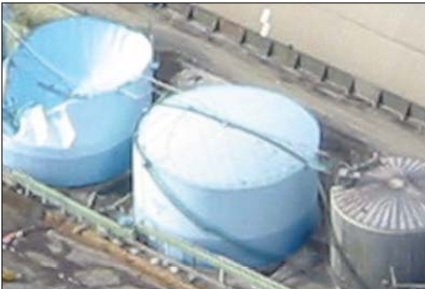
Figur 2:1 Cistern med fast tak 16 (Kemira olyckan 2005, Helsingborg)
