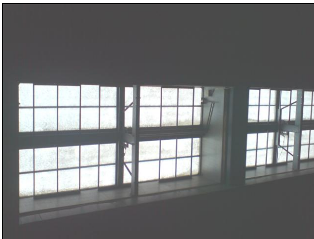
Figur 7. Rökluckorna i taket i backhallen. (Foto: Andersson S, 2007)
