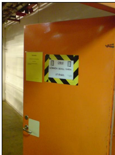
Figur 5. Brandklassad dörr utan självstängare i backhallen. (Foto: Andersson S, 2007)
