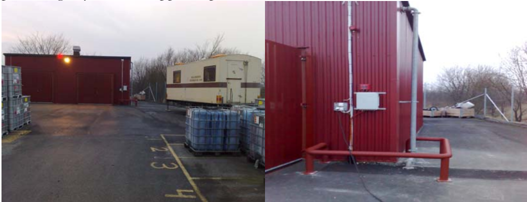
Bild 23. Det nya nitroförrådet.
