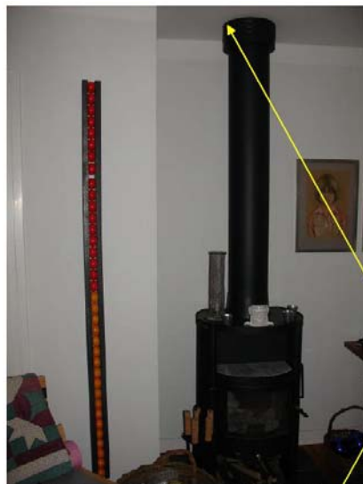
Skorstensgenomföringen i tvillinghuslägenheten.
