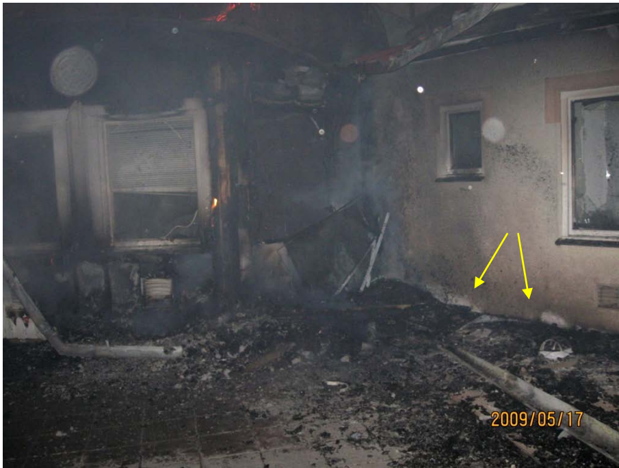
Figur B 21. Bilden tagit cirka klockan 01.30 av polisen. Bilden indikerar en brandplym mot hörnet (ljusinställningar har ändrats).
