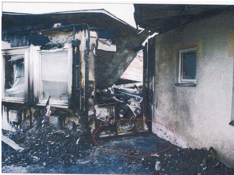
Platsen där brandens primärområde bedömdes vara har frilagts från brandrester. Markerat på bilden.
