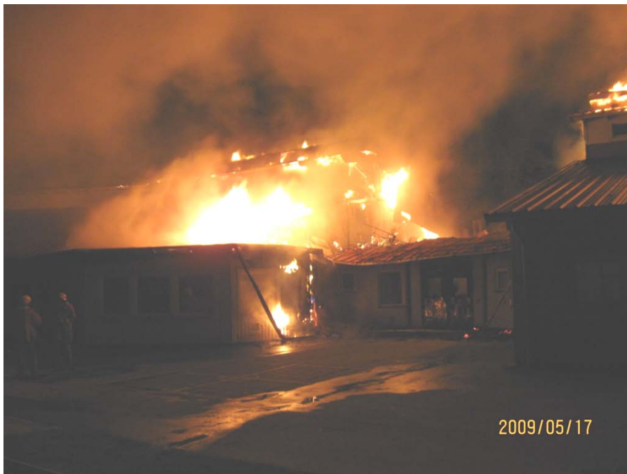
Figur B 19. Bilden tagit vid klockan 01.30. Man ser redan att det primära området har brunnit ordentligt och att en del av väggen/taket har rasat i hörnet. (ljusinställningar har ändrats) Bilden är tagen från polisen.
