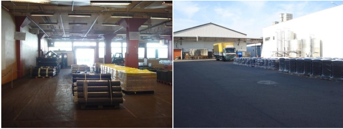
Figur 5.3 Utlastning övriga kunder (t.v.) och utlastningsplats övriga kunder (t.h.).
