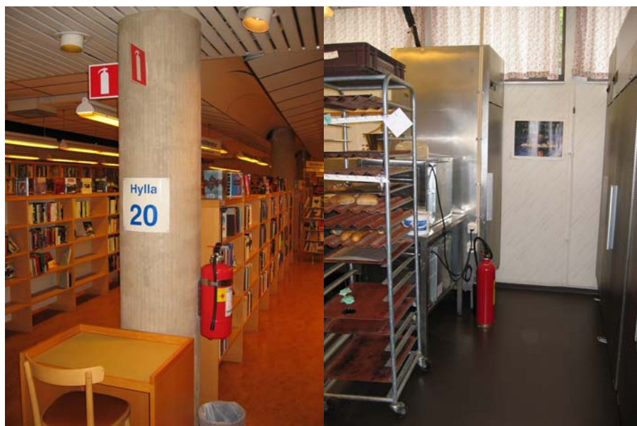
Figur 2.10 Skumsläckare i biblioteket. Ej monterad kolsyresläckare i köket på Café Sjöbris
