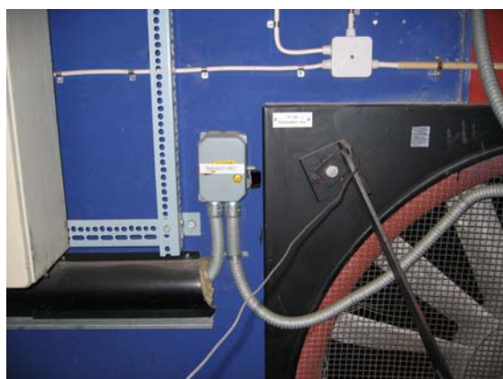
Figur 2.9 Brandgasventilation över scenen
