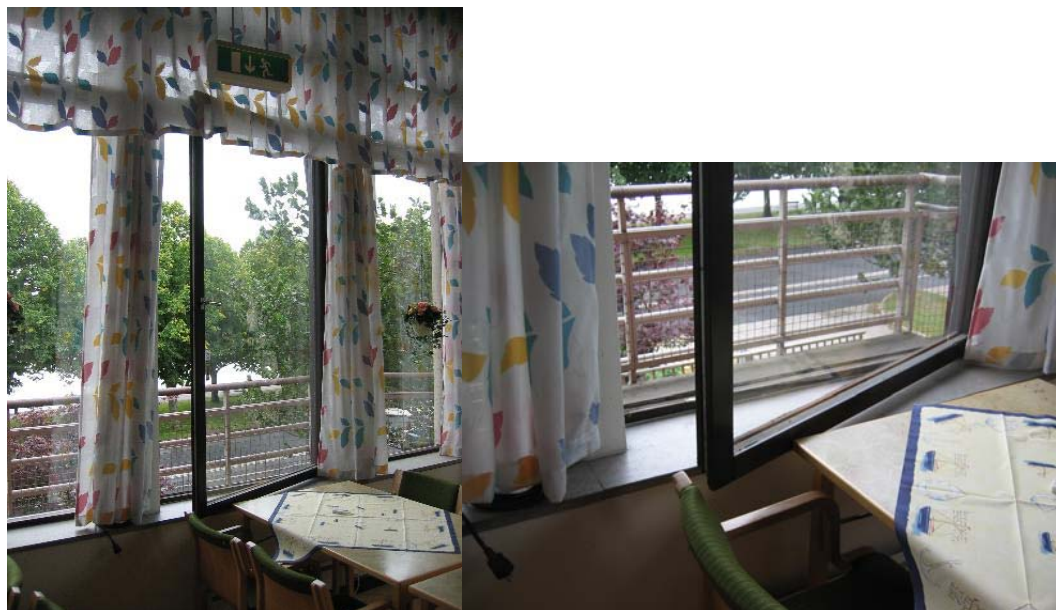
Figur 5.4 Blockerad nödutgång
