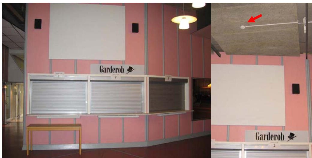
Figur. 3.6 Garderob sett från foajén. Till höger ses rökdetectorn ovanför jalusierna
