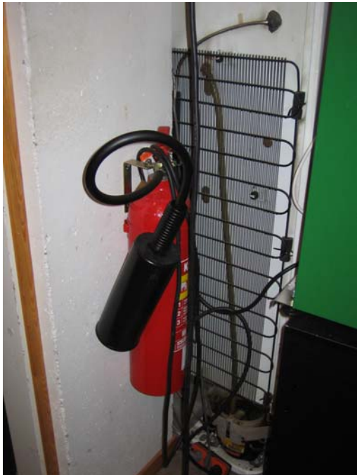
Bild 3.5 Övertäckt handbrandsläckare
