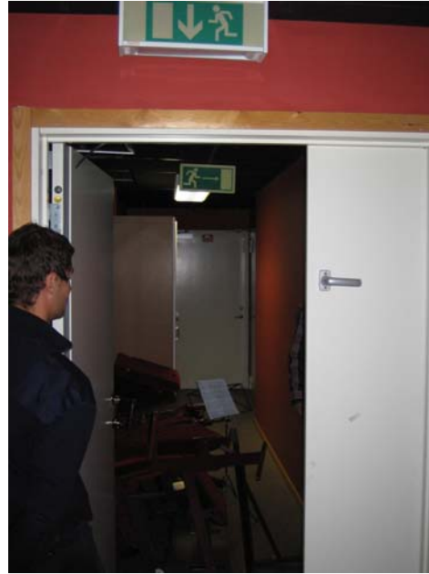
Bild 3.8 Bråte i utrymningsväg.
