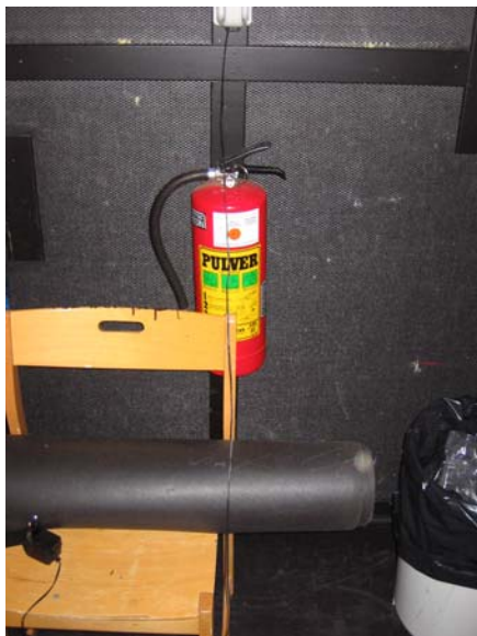
Bild 3.9 Svåråtkomlig handbrandsläckare.
