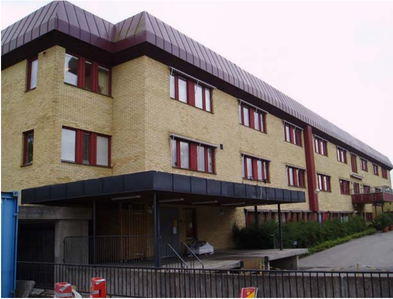
Figur 2.2, Byggnad 1 med avdelningarna PIVA och beroende på våning 3
