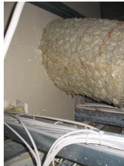
Figur 2.6 och 2.7, Genomförning i brandcellsgräns ovan undertaket.
