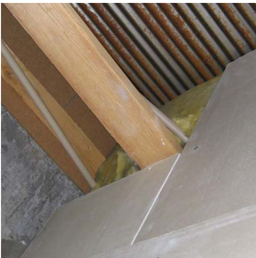
Figur 2.6 och 2.7, Genomförning i brandcellsgräns ovan undertaket.
